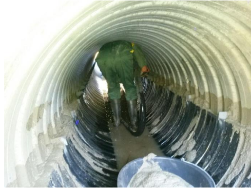
Notkistuksen jälkeen massa valui helposti välitilaan.
