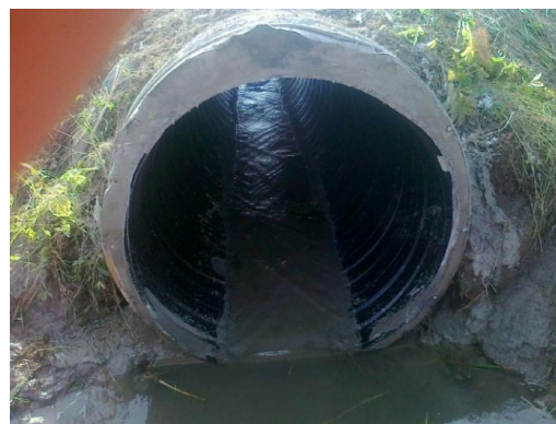
Työ valmiina kun muotit on purettu. Kuvassa alajuoksun ja uretaanin puoleinen pääty.
