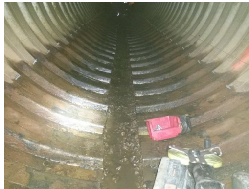
Pitkän roilon liikettä seurattiin leikkauksen aikana ja supistumista oli korkeintaan 10mm.
