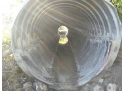
Päätyjen kolot ja epätasaisuudet tasoitettiin (Arsalin Oy:n Jeti-S) pikabetonilla.
