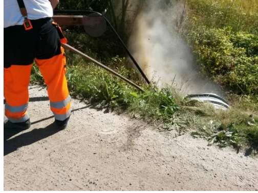
Lokapalvelu Eerola pesee putken tähän tarkoitukseen sopivalla suuttimella.
