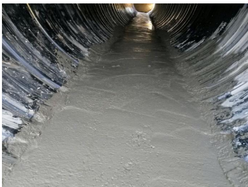
Pohjalle valettiin keskeltä 5-6cm vahvuinen laatta. (Rudus C30/37 P20 #8 S3) massalla
