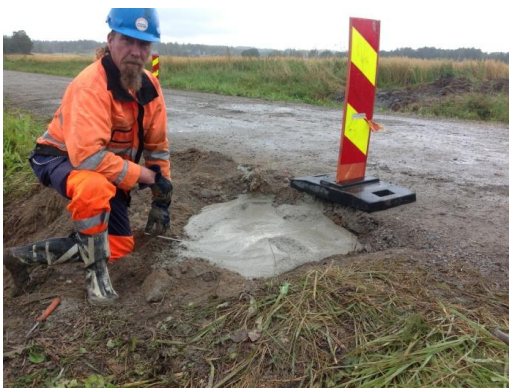
Kun välitila oli betonoitu, jätettiin valaukon päälle ns. "paineastia".
