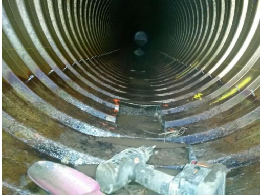
Yläjuoksulta etäisyydelle 0-11 m tehtiin ankkurointikoloja 360 x 200mm k 900
