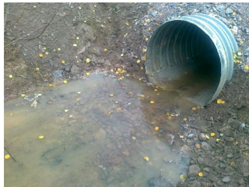
Betoni oli C30/37 P25 #16 S2 + teräskuitu 1/50 ja menekki n. 2,5m 3 . Työ valmis yläjuoksulla.
