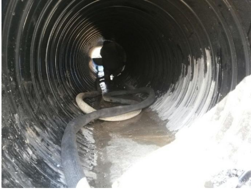
Uretaanitäyttö käynnissä. Täyttö tehtiin noin 5,4m osuudelle.
