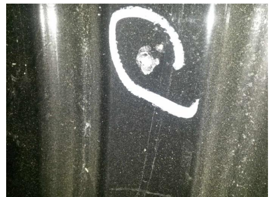
Seuraavassa vaiheessa Uretaanipojat Oy porasi täyttöreikiä putken sisäpuolelle.
