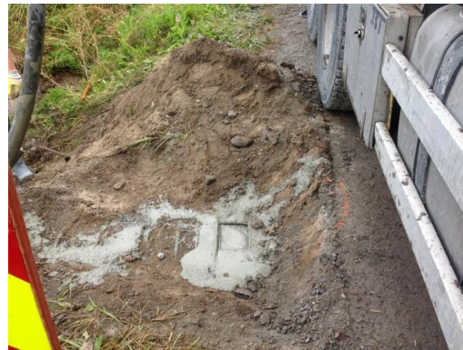
Betoni oli (C30/37 P20 #8 S4) jota notkistettiin työmaalla.
