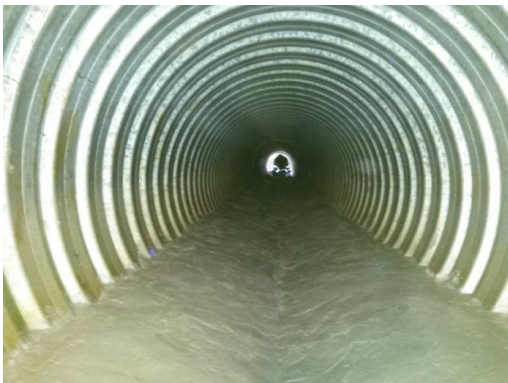
Pohjalle pumpattiin betoni joka muotoiltiin käsin niin että vesijuoksu säilyy reunoja alempana.
