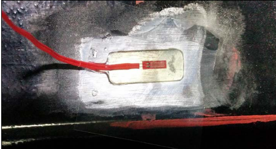
Kuva 3.2 Venymäliuska liimattuna rummun laelle. Ennen liimaamista rummun pinta hiottiin hiomapaperilla ja puhdistettiin asetoniin kastetulla paperilla.
