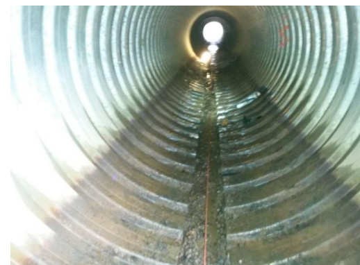
Alajuoksulta etäisyydelle 0-11m leikattiin 15cm leveä ja 8-10cm syvyinen ankkurointiroilo.
