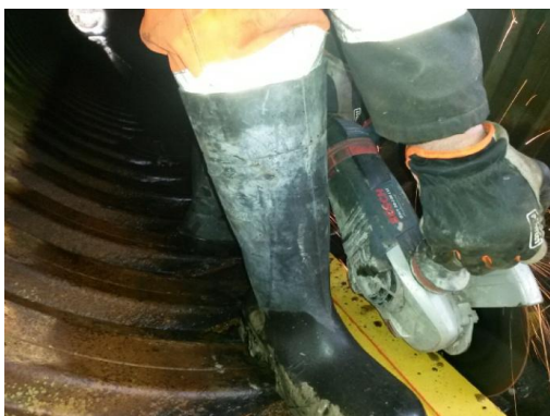
Leikkaukset tehtiin katkaisulaikalla. Paalusaha olisi soveltunut tähän paremmin.
