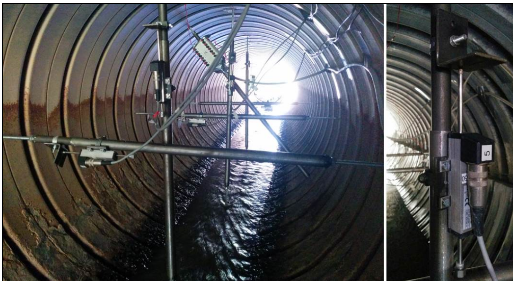
Kuva 3.1 Vasemmalla: Siirtymäanturit asennettuna rummun sisälle. Mittausanturi koostui teräsputkista tehdystä rungosta sekä siirtymäanturista 50 mm liikevaralla. Oikealla: lähikuva mittausanturin runkoon kiinnitetystä siirtymäanturista ja sen vastakappaleesta.
