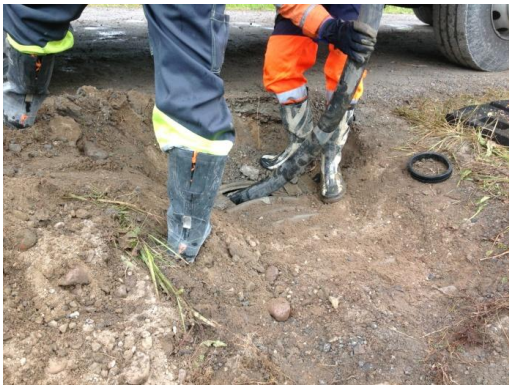
Välitilan betonointi toteutettiin avaamalla vanhan rummun selkä luiskan kohdalta.
