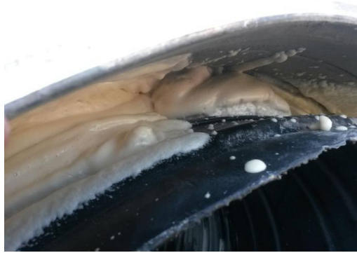
Uretaanitäyttö jätettiin päädyistä vajaaksi myöhempää betonointia varten.
