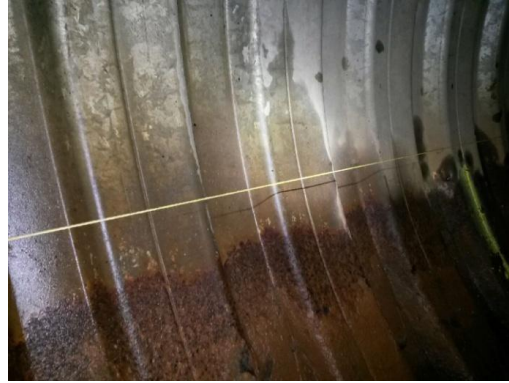
Valun yläreuna merkattiin linjalangalla niin että se peittää kaikki ruostekohdat.
