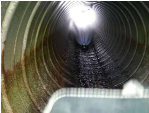
Ojan padotettiin jonka jälkeen Lokapalvelu Eerola pesi rummusta vähäiset maa-ainekset.
