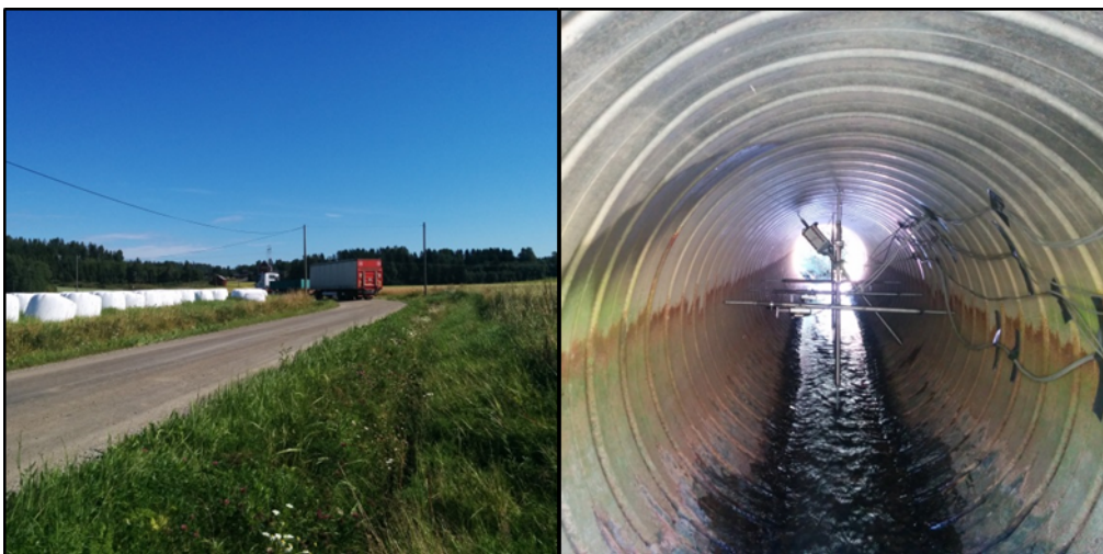
Kuva 2.1 Romsarbyntie 128, Raasepori. Vasemmalla on esitettyä yleiskuva koe-kohteen tiestä, joka oli sorapäälysteinen ja vähäliikenteinen. Oikealla on esitettyä kuva rummun sisältä mittauslaitteisto asennettuna. Rummun halkaisija oli 1000 mm ja peitesyvyys vaihteli 0,20...0,35 m välillä. Rummun alaosassa oli pintaruostetta hieman yli poikkileikkauksen puolenvälin.
