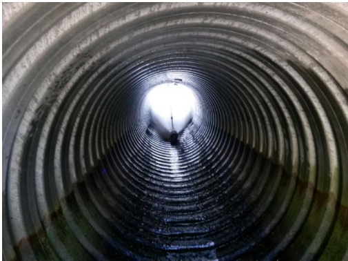
Suutinta liikutellaan putkessa edestakaisin kunnes putki on tyhjä. Kuva alajuoksun suuntaan.
