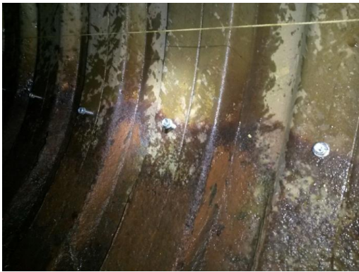
Yläjuoksulta etäisyydelle 0-5,5m ja 11-16,5m asennettiin tartunnaksi poraruuvit.
