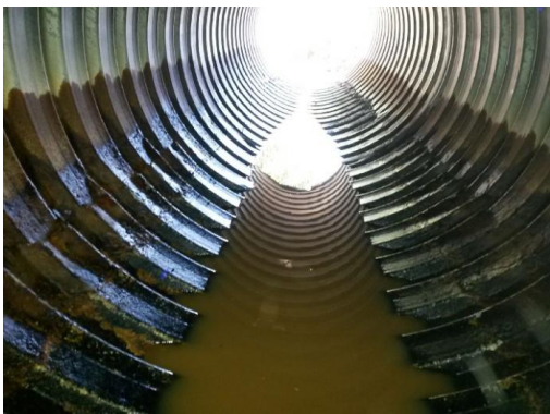
Kuva yläjuoksun suuntaan. Täällä korrosio on nakertanut putkea siististi molemmilta puolin.
