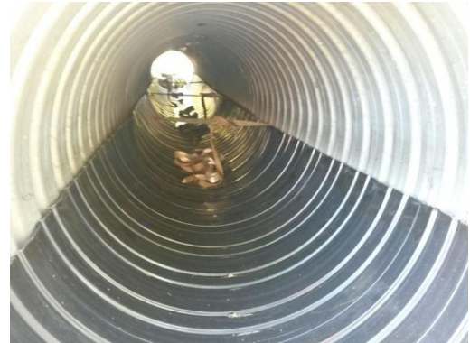
(ViaCon TR-1000 PE300/300 1,5mm) sujutettiin kirstysliinoja apuna käyttäen
