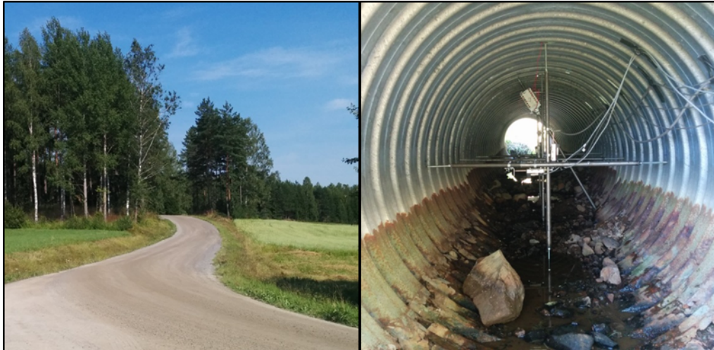
Kuva 2.3 Rankilantie 306, Inkoo. Vasemmalla on esitettyä yleiskuva koekohteen tiestä, joka oli sorapäällysteinen ja vähäliikenteinen. Oikealla on esitettyä kuva rumpun sisältä mittauslaitteisto asennettuna. Rumpun halkaisija oli 1200 mm ja peitesyvyys vaihteli 0,30...0,90 m välillä. Rumpu oli ruostunut puhki alaosaan ja lisäksi reunoilla oli havaittavissa pintaruostetta.
