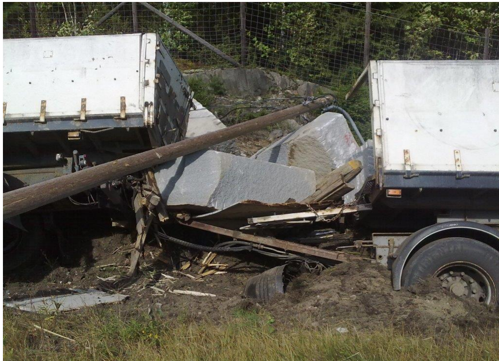
Kuva 4. Onnettomuustilanne, jossa raskas ajoneuvo on kyntänyt maakaapelin esiin. (kuva: Heikki Ikonen)
