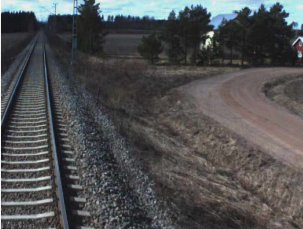
Kuva 7.1 Kokemäki–Rauma-rataosan havaintopenkereen D kohdalta RailwayDoctorista kaapattu kuva laserkeilainmittausten ajankohtana. Pengerluiskissa on havaittavissa jonkin verran pintakasvillisuutta, mutta varsin vähän varsinaista vuosittaisen kasvukauden aikana muodostuvaa kasvillisuutta.
