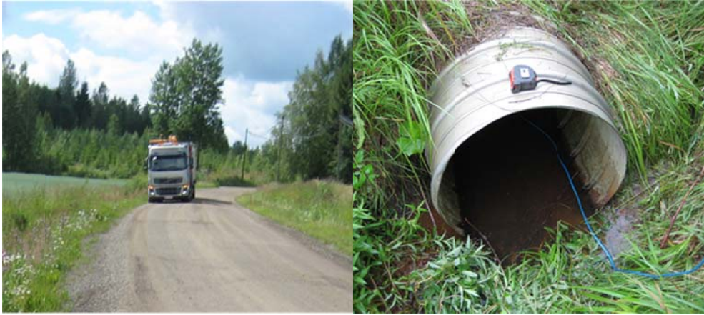
Kuva 2.2 Teräsrumpu, halkaisija 800 mm, peitesyvyys 750 mm. Vasemmalla yleiskuva tiestä, jossa rumpu sijaitsee. Oikealla kuormitettava rumpu.
