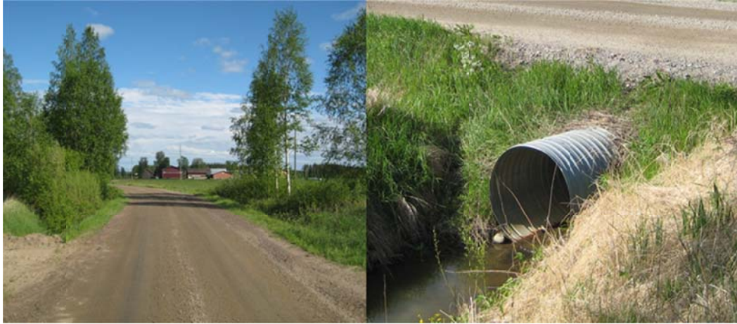
Kuva 2.3 Teräsrumpu, halkaisija 1000 mm, peitesyvyys 500 mm. Vasemmalla yleiskuva tiestä, jossa rumpu sijaitsee. Oikealla kuormitettava rumpu.
