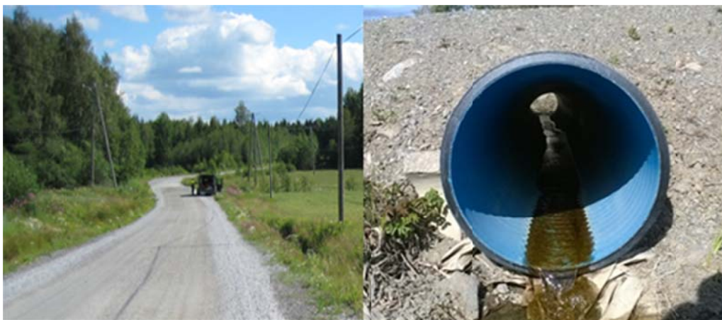
Kuva 2.7 Muovirumpu, halkaisija 600 mm, peitesyvyys 500 mm. Vasemmalla yleiskuva tiestä, jossa rumpu sijaitsee. Oikealla kuormitettava rumpu.
