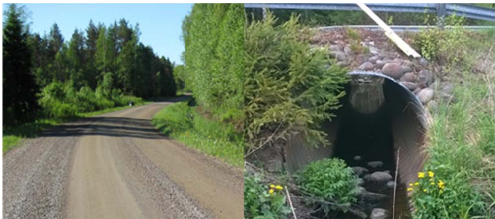
Kuva 2.4 Teräsrumpu, halkaisija 1400 mm, peitesyvyys 500 mm. Vasemmalla yleiskuva tiestä, jossa rumpu sijaitsee. Oikealla kuormitettava rumpu.
