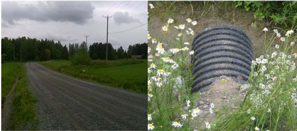
Kuva 2.6 Muovirumpu, halkaisija 600 mm, peitesyvyys 650 mm. Vasemmalla yleiskuva tiestä, jossa rumpu sijaitsee. Oikealla kuormitettava rumpu.
