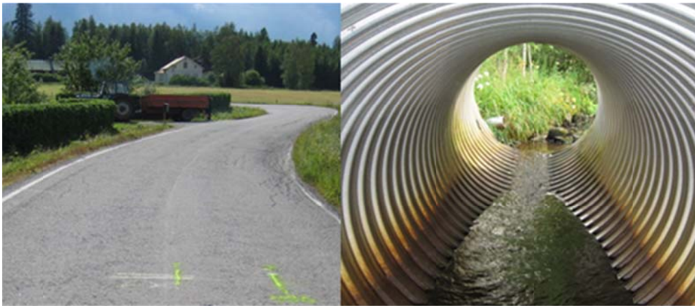
Kuva 2.5 Teräsrumpu, halkaisija 1800 mm, peitesyvyys 900 mm. Vasemmalla yleiskuva tiestä, jossa rumpu sijaitsee. Oikealla kuormitettava rumpu.
