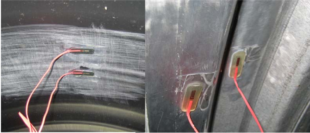
Kuva 3.3 Venymäliuskat asennettuna rummun seinämään. Vasemmalla muovirumpu ja oikealla teräsrumpu. Teräsrummun venymäliuskoista vasemmanpuoleinen on asennettu aaltoprofiilin pohjalle ja oikeanpuoleinen harjalle. Muovirumpujen sisäpinnassa ei ole aaltoprofiilia, vaan pinta on sileä.
