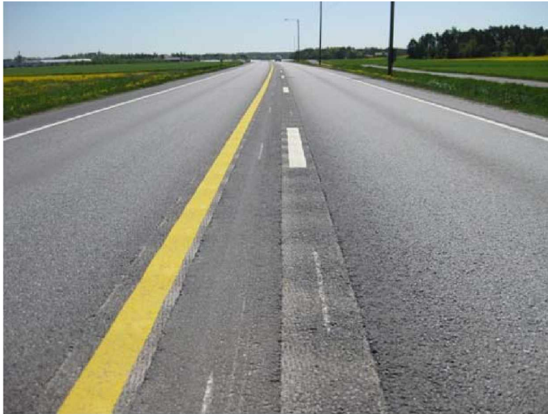
Kuva 1. Laitilan leveän keskimerkinnän koetie. Laitilassa käytettiin sinijyrsintää ja jyrsittiin keskialueelle aina kaksi rinnakkaista pituussuunnassa syvyydeltään vaihtelevaa uraa.
