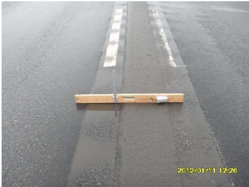
Kuva 9 Vettä jyrshintäurissa Laitilassa 11.1.2012.
