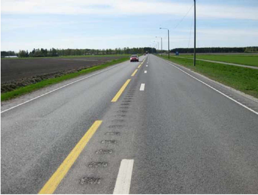
Kuva 3 Laihian leveän keskimerkinnän jyrinnät tehtiin samaan tapaan kuin Noormarkussa, mutta ajokaistan leveys oli keskimäärin n. 0,2 m leveämpi kuin Noormarkussa.
