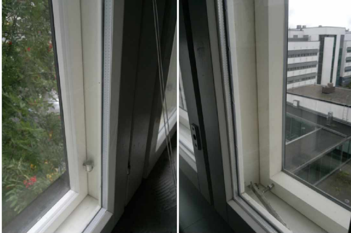
Kuva 5.2.3.1 Vasemmalla karmisyyvydeltään 170mm ikkuna ja oikealla 210 mm ikkuna
