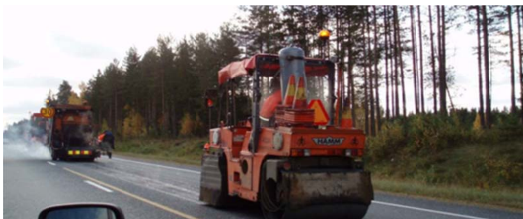
Kuva 10. Tien pinnan lämmitystä korjausvaiheessa (Katri Eskola, Liikennevirasto)
