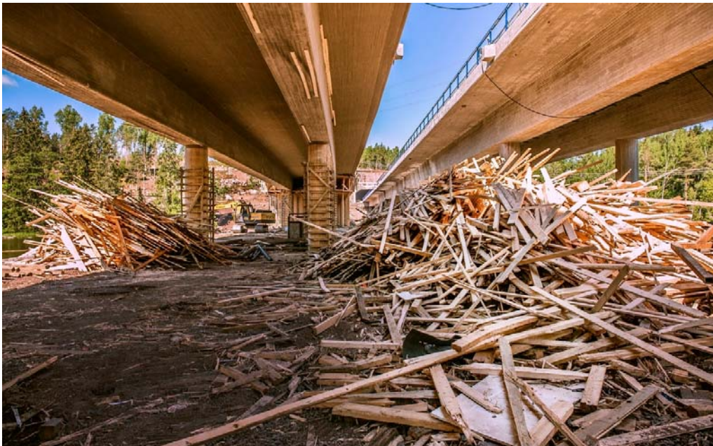
Kuva 8. Puisten puutelineiden purkua siltatyömaalla (Liikennevirasto)
