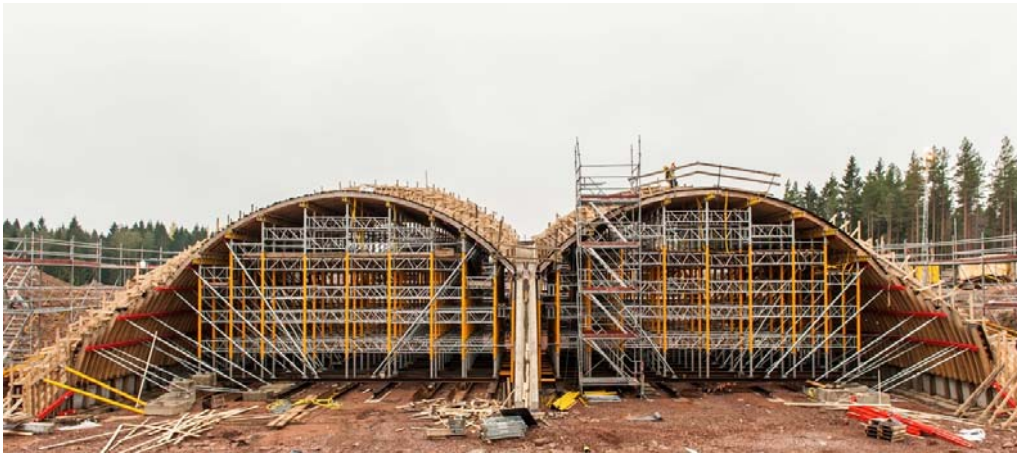
Kuva 7. Terästelineitä siltatyömaalla (Liikennevirasto)
