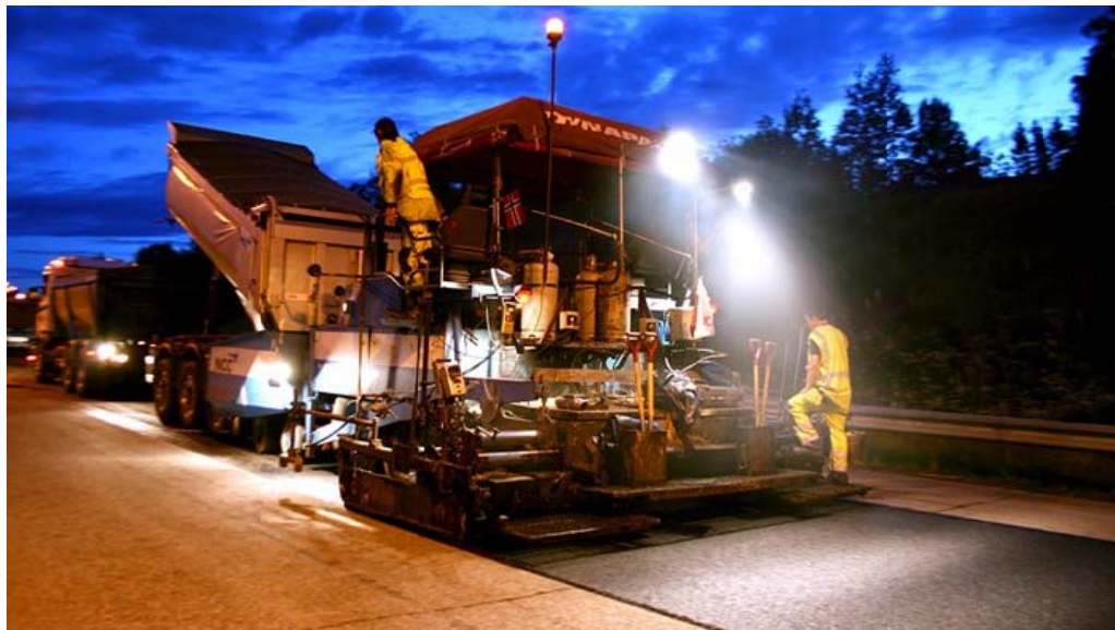
Kuva 9. Asfaltointia Remix-menetelmällä (NCC)
