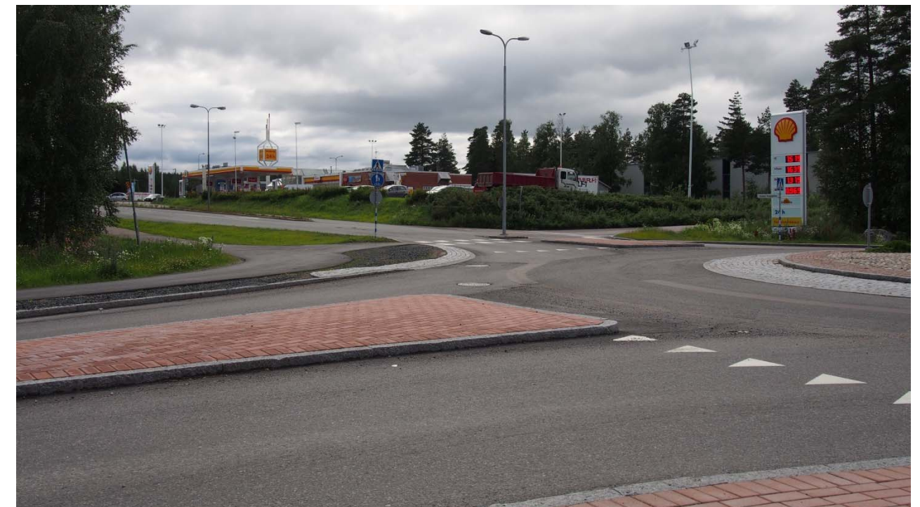
Kuva 8. Vielä heinäkuussa 2015 Elovainion kiertoliittymien saarekkeissa oli korkeat reunakivet, ja yliajettavaa osuutta oli vähän (kuvat: Kimmo Heikkilä).
