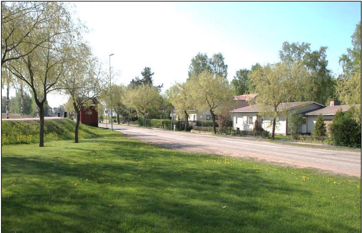
Bild 7.2.3-2. Översvämningsvallen i Lovisa centrum och i bostadsbyggnaderna i bakgrunden vid Strandvägen. (Foto: FCG Suunnittelu ja tekniikka Oy, av den 23.5.2014)
