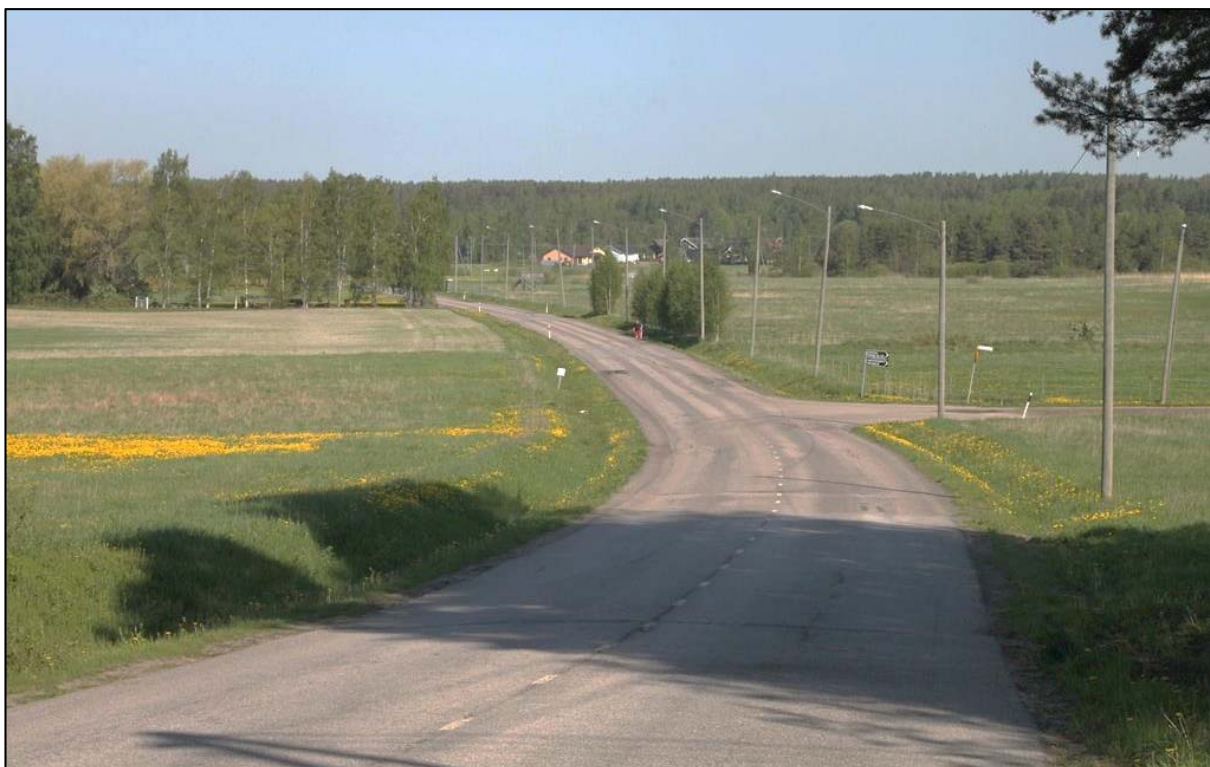
Bild 7.2.4-2. Kring Gamla Valkomvägen täcker översvämningen stora arealer av åker- och ängsmark. Vägförbindelsen Gamla Valkomvägen bryts redan vid en 1/2a havsöversvämning ( N_{2000} +1,38 ). (Foto: FCG Suunnittelu ja tekniikka Oy, av den 23.5.2014)
