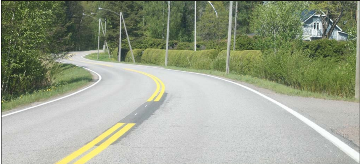
Bild 10.3.1-2. Skärgårdsvägen skärs av vid Määrlahti vid en 1/100a havsöversvämning ( N_{2000} +2,22 ). (Foto: FCG Suunnittelu ja tekniikka Oy, av den 23.5.2014).
