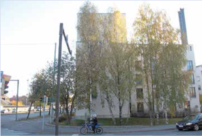
Bild 16. Tilluften tas från höga rör på byggnadens skyddade sida. Foto Hannu Airola.
