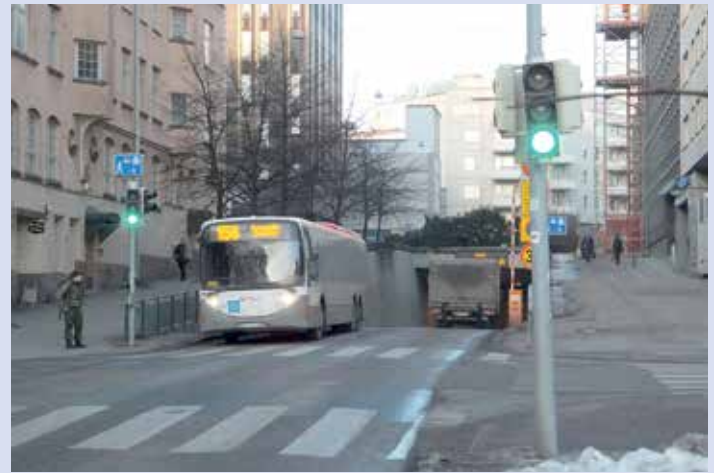
Bild 19. Frånluftsroren från en trafikunnel kan vara ett problem med tanke på luftkvaliteten. Foto Hannu Airola.
