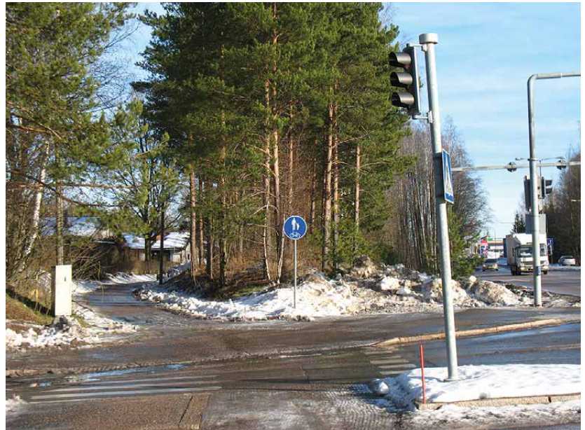
Kuva 14. Viherkaista ajoradan ja kevyen liikenteen väylän välissä on ilmansuojelun kannalta hyvä ratkaisu. Kuva Hannu Airola.
