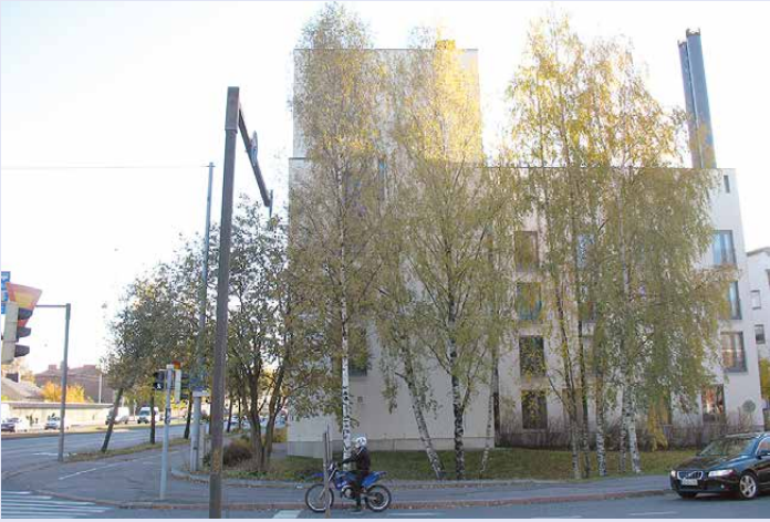
Kuva 16. Tuloilma otetaan korkeista torvista rakennuksen suojanpuolelta. Kuva Hannu Airola.
