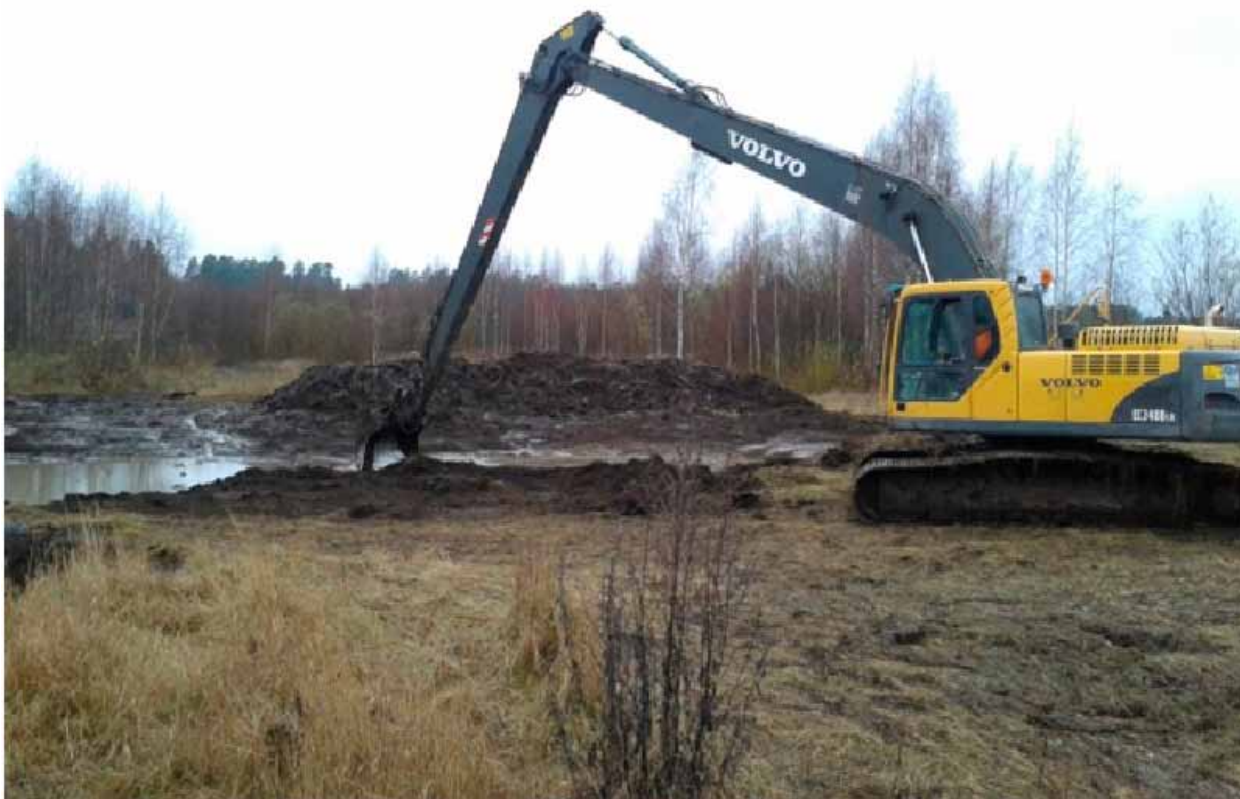
Kuva 42. Pitkäpuomiset koneet ovat tehokkaimpia kosteikkojen kaivussa. Kuva Janne Raassina
