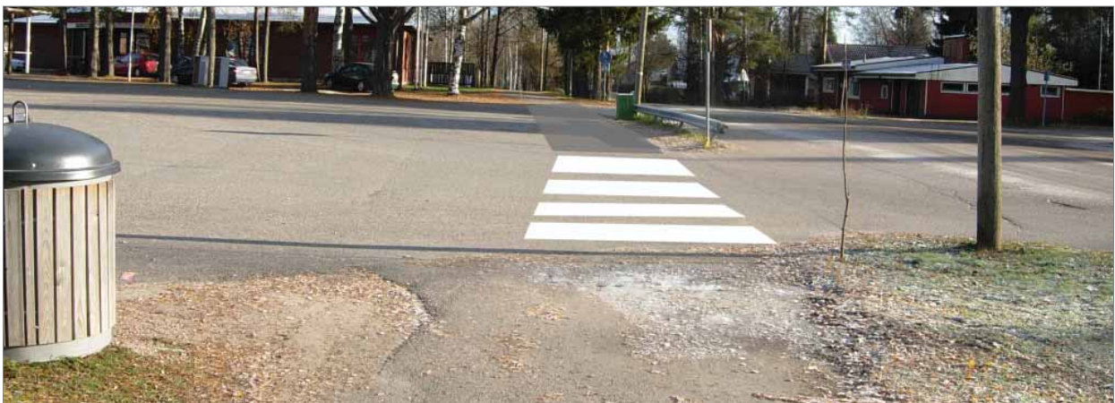
Kuva 7. Uimahallin piha-alueen kohdalle rakennetaan jalanku- ja pyörätie.
