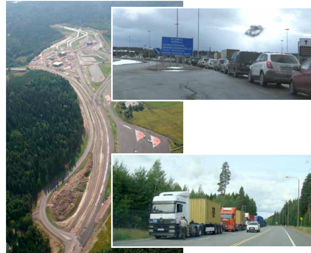
Kuva 1.3. Nuijamaan raja-asema (nykyisten järjestelyjen rakentamisaikana vuonna 2005). Lisääntynyt rajaliikenne ruuhkautuu säännöllisesti raja-aseman läheisyydessä ja rekkajonot aiheuttavat ongelmia liikenteen sujuvuudelle, turvallisuudella ja kunnossapidolle.
