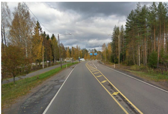
Kuva 13. Vt 6 Karjalantien ja Rautjärvellä sijaitsevan Tehtaantien liittymän tiimerkinnöillä toteutetut kanavoinnit parannetaan reunakivetyiksi saarekkeiksi (lähde: Google Maps 9.6.2014).
