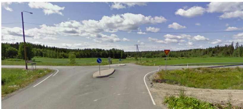
Kuva 10. Vt 13 Nujamaantien, Jysinmäentien ja Vortsantien liittymä, jossa väistämisvelvollisuusmerkki muutetaan STOP-merkiksi ja pysäytysviivaksi (lähde: Google Maps, 9.6.2014).
