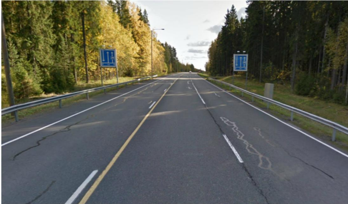
Kuva 12. Vt 13 Nuijamaantie, Nuijamaan raja-asemalta Lappeenrannan suuntaan ajettaessa voidaan harkita ohitusmahdollisuuden poistamista ja keskimerkinnän muuttamista sulkuviivaksi molempiin suuntiin (lähde: Google Maps 9.6.2014)
