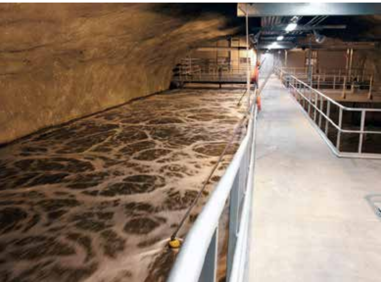
Turun Kakolanmäen jätevedenpuhdistamo. Kuva: Turun seudun puhdistamo Oy.
