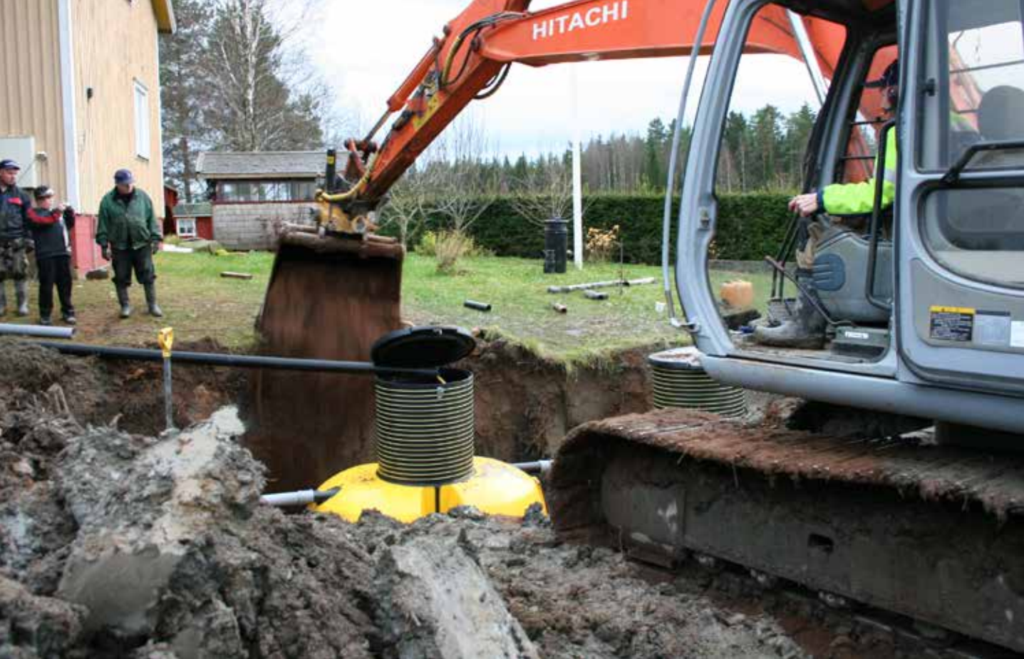
Pienpuhdistamo on helppo sijoittaa tontilla, mutta sen käyttö ja huolto on vaativampaa kuin maapuhdistamon. Kuva: Tero Forsman
