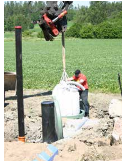
Fosforinpoiston voi toteuttaa esimerkiksi puhdistamon perään asennettavalla fosforinpoistokaivolla. Kuva: Minna Nummelin
