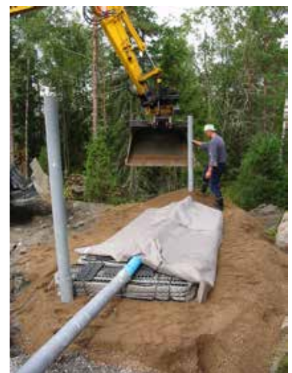
Moduuleilla maasuodattamon saa toteutettua pienempään tilaan. Kuva: Minna Nummelin
