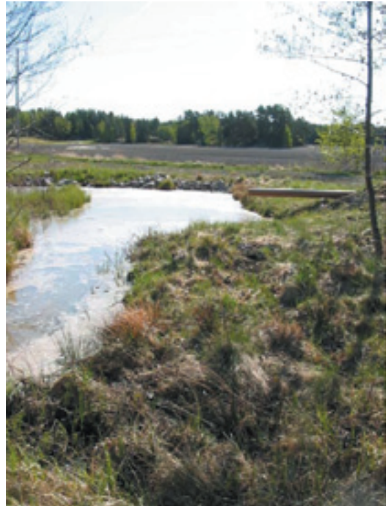
Kuva 10. Saostusallas ja purkuputki puhdistamosta. Kemiakaalikäsittelyssä syntyy kevyttä, vaahdontaista ainesta, joka painuu vähitellen altaan pohjaan. Kuva: Turun kaupunki/Ympäristönsuojelutoimisto
