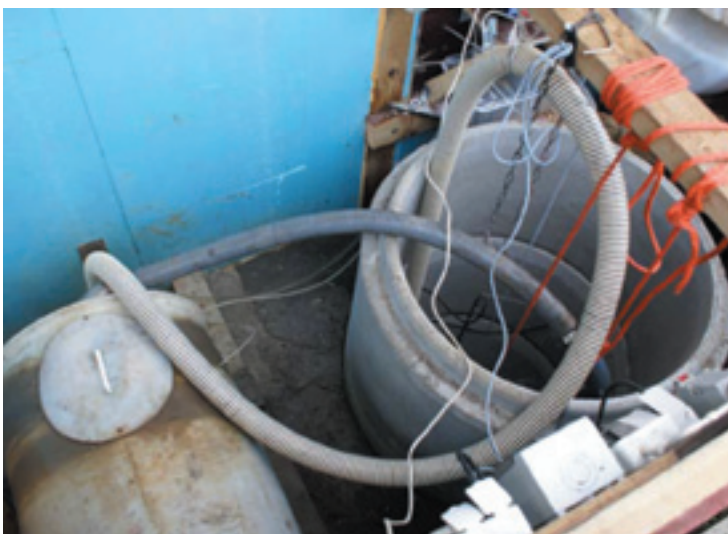
Kuva 11. Saostuskemikaalin lisäslaitteistoa. Kuva: Airi Kulmala
