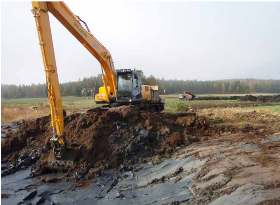
Kosteikon kaikki muodot tulee rakentaa loivapiirteisinä ja tiiviisti. Kuva: Ilkka Myllyoja
