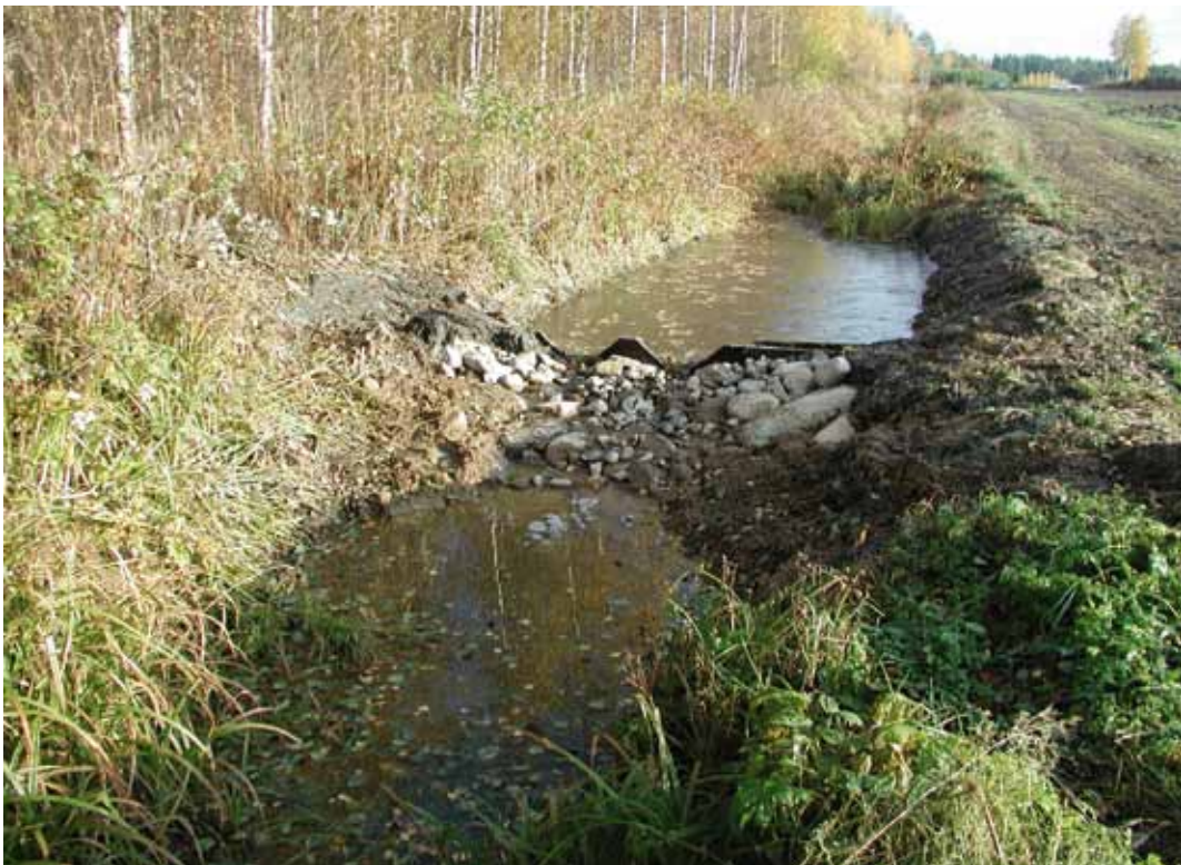
Pieni vanerilevystä ja kivistä rakennettu pohjapato valtaojassa. Tavoitteena on kerätä karkeaa kiintoainesta. Kuva: Henri Vaarala / Pyhäjärvi-instituutti
