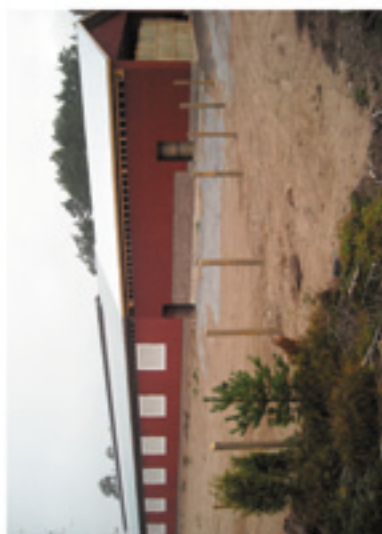
Tarha on haketta, verhoaa ja siltäalankaa vaille valmis. Haketta levitetään alueelle n. 10000 m 3 .
