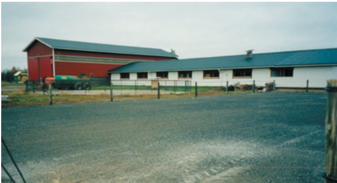
Kuvat 12 ja 13. Masuunikuonasta tehty maabetonitarha sateen jäljiltä (kuva 12)
