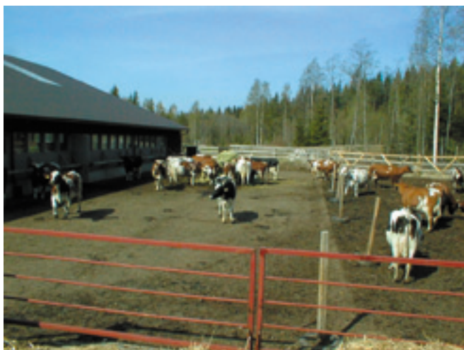
Kuva 11. Navetan vieressä, vasemmalla puolella asfalttitarha, joka on erotettu kuoriketarhasta 10 cm korkealla reunuksella. Valumavedet valuvat kuvan alareunassa sijaitsevaan keräilykaivoon. Kuva: Maarit Hellstedt
