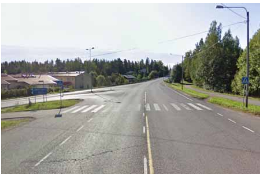
Kuva 31. Klaukkalantien ja Kirkkotien liittymä. (Lähde: Google Maps)
