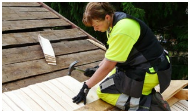
Pärekaton rakentamista Mäntyharjun pappilan kunnostustöissä kesällä 2011. Kuva: Ympäristönhoitotyöt Etelä-savossa -hanke.
