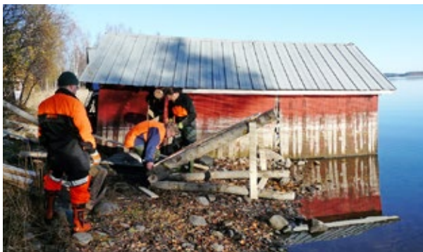
Anttolan venevajojen kunnostustyöt käynnissä. Kuva: Ympäristönhoitotyöt Etelä-savossa -hanke.
