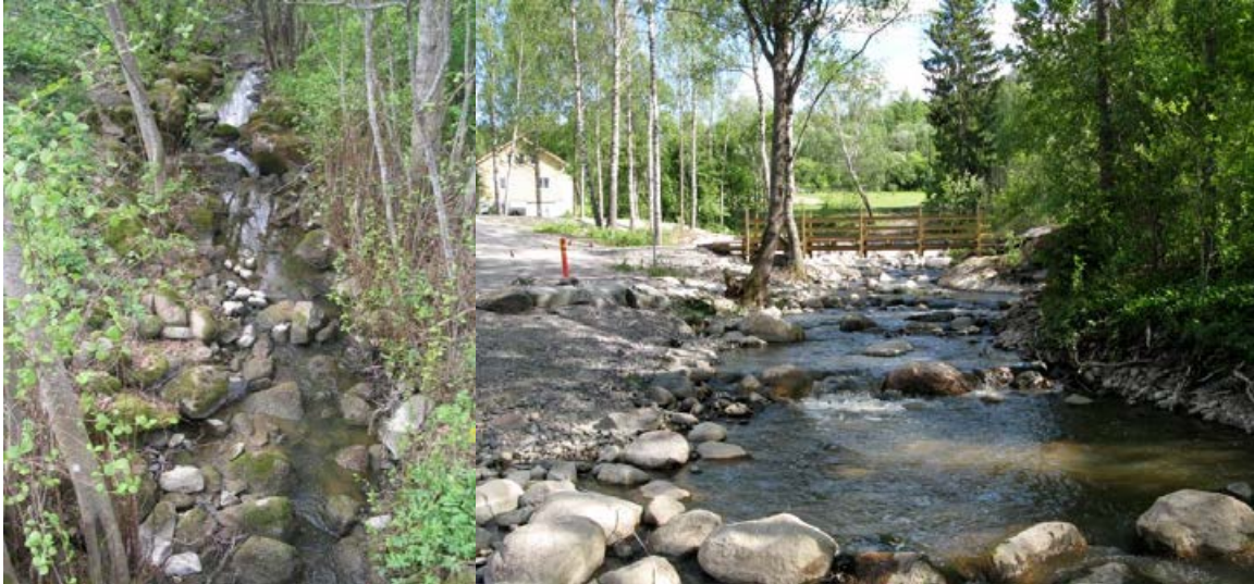
Kuva 14. Vasemmalla padon kiertävä kapea ja vähävetinen sivu-uoma ennen kunnostusta vuonna 2006. Oikealla sama sivu-uoma kalatieksi avattuna ja kivettynä vuonna 2008 ylävirtaan tarkasteltuna. Vasen kuva: Esa Lehtinen, oikea kuva: Reetta Ljungberg.
