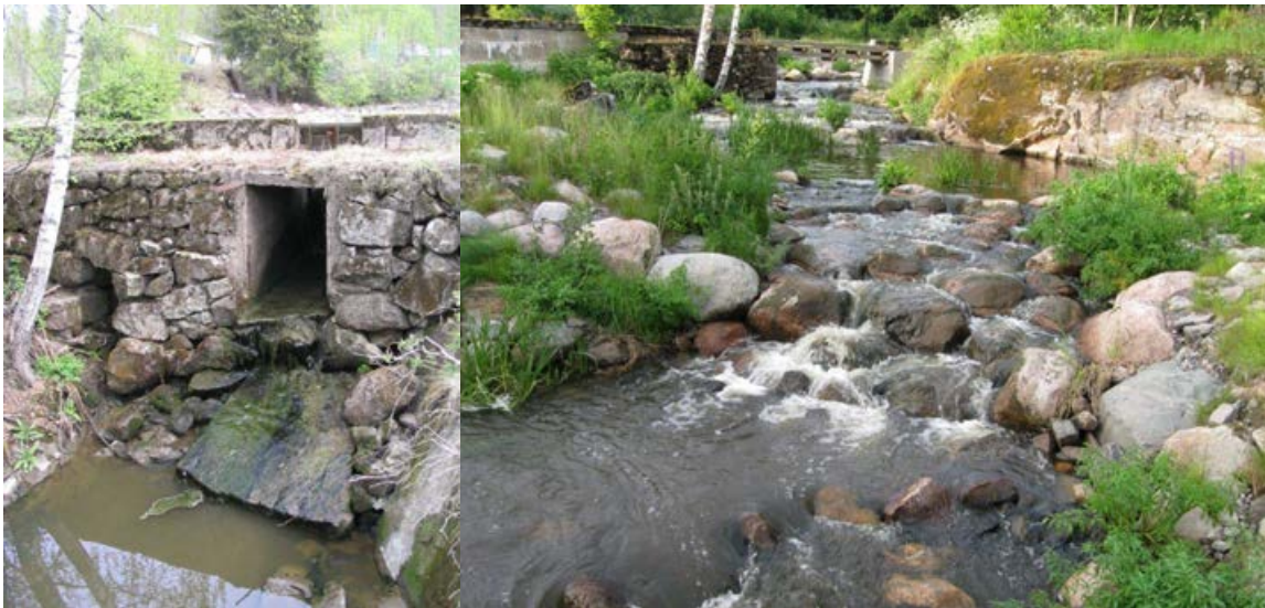
Kuva 13. Vasemmalla padon kiertävän sivu-uoman purkautumisaukot ennen kunnostusta vuonna 2006. Oikealla sama sivu-uoma kunnostettuna ja muuri puhkaistuna ylävirtaan tarkasteltuna vuonna 2010. Kuvat: Esa Lehtinen.
