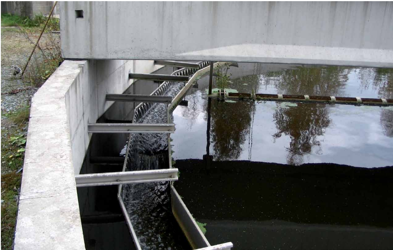
Kuva 8. Keuruun Jaakonsuon jätevedenpuhdistamon jälkiselkeytsaltaasta poistuvaa vettä. Kuva: Jukka Mutila.
