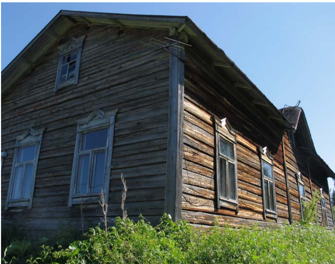
Kuva 47. Kemijokivarressa on komeita peräpohjalaisia taloja. Kuvassa Arvospuolen Lehtolan vanha päärakennus.
