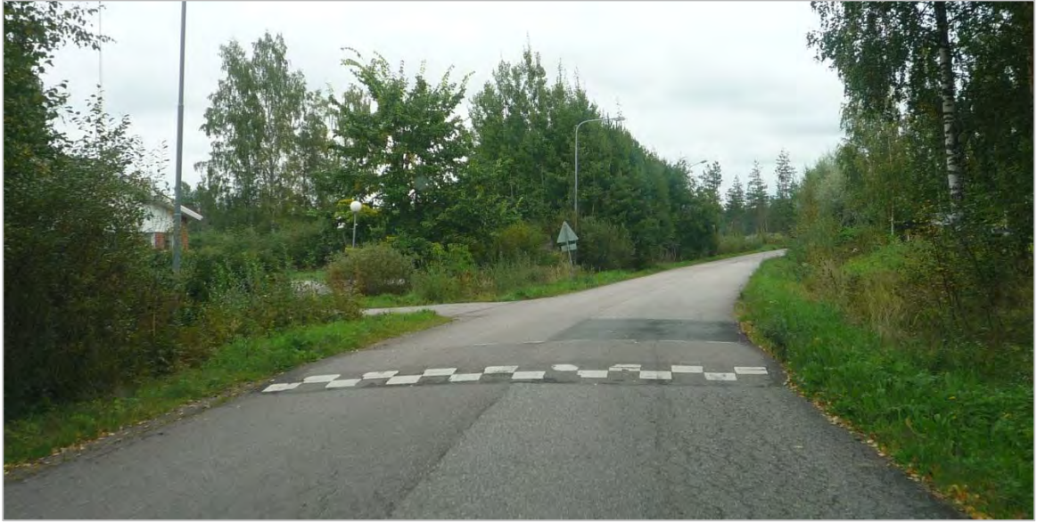
Kuva 20. Esimerkki Pornaisissa asuinalueen katuverkolla olevasta hidasteesta.
