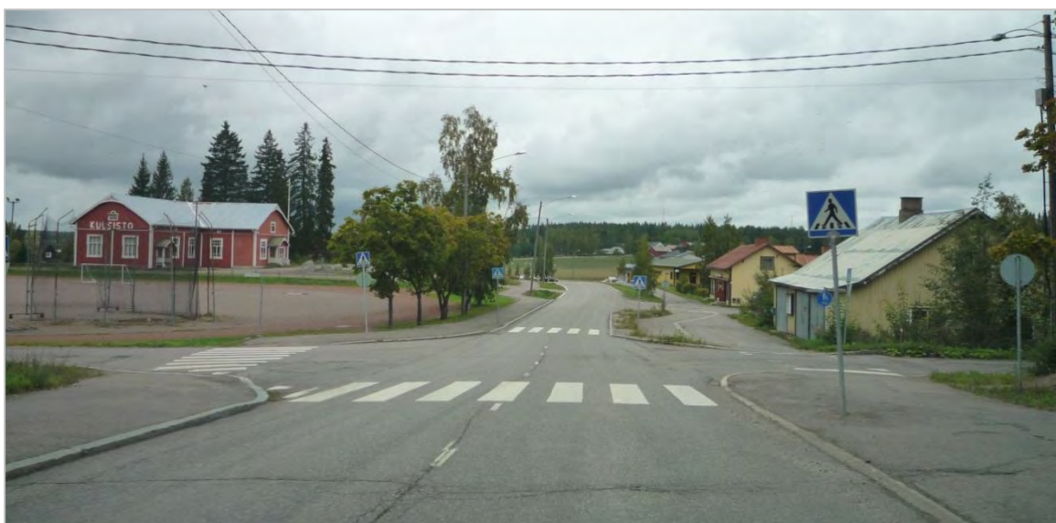
Kuva 23. Koululaisten tienylityskohta koulun ja urheilukentän välillä (toimenpiteenä kuvassa kauimmaisena näkyvän suojatien korottaminen).
