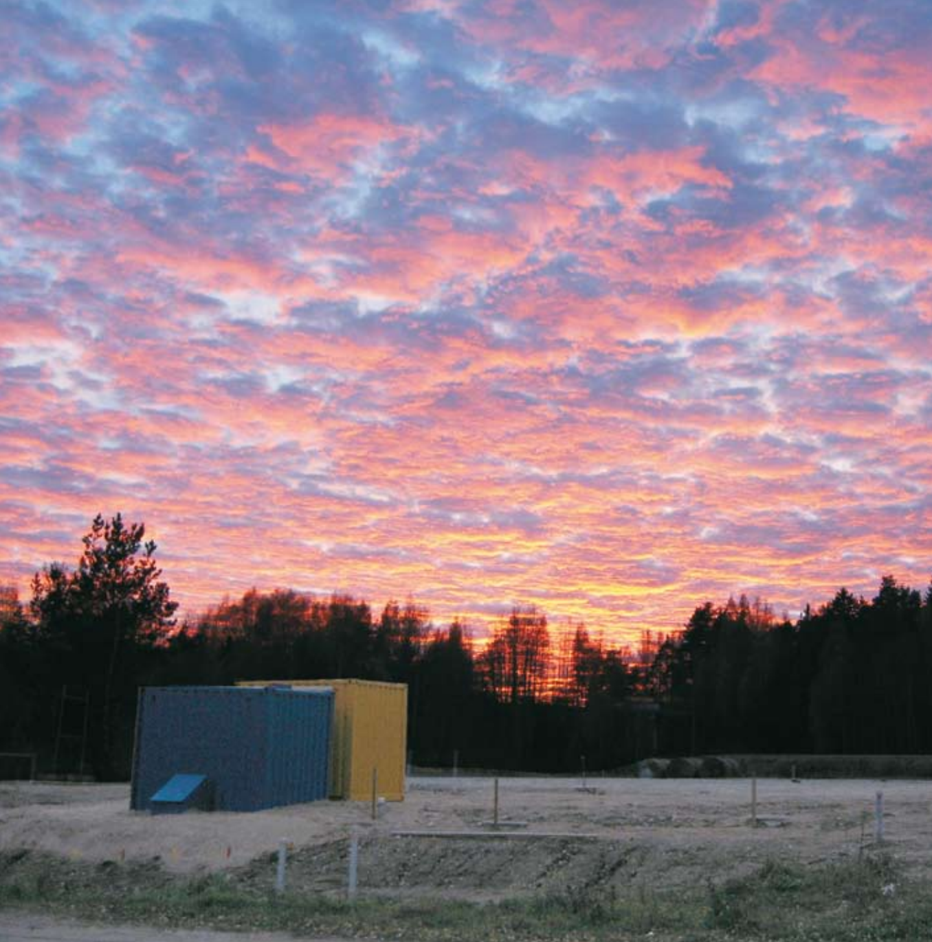
Mikkelin Pursialan pohjavesialueella sijaitsevan entisen kyllästyksen koekunnostustyömaa lokakuussa 2005. Kuva Anne Petäjä-Ronkainen, kuvan käsittely Vesa Väisänen.
