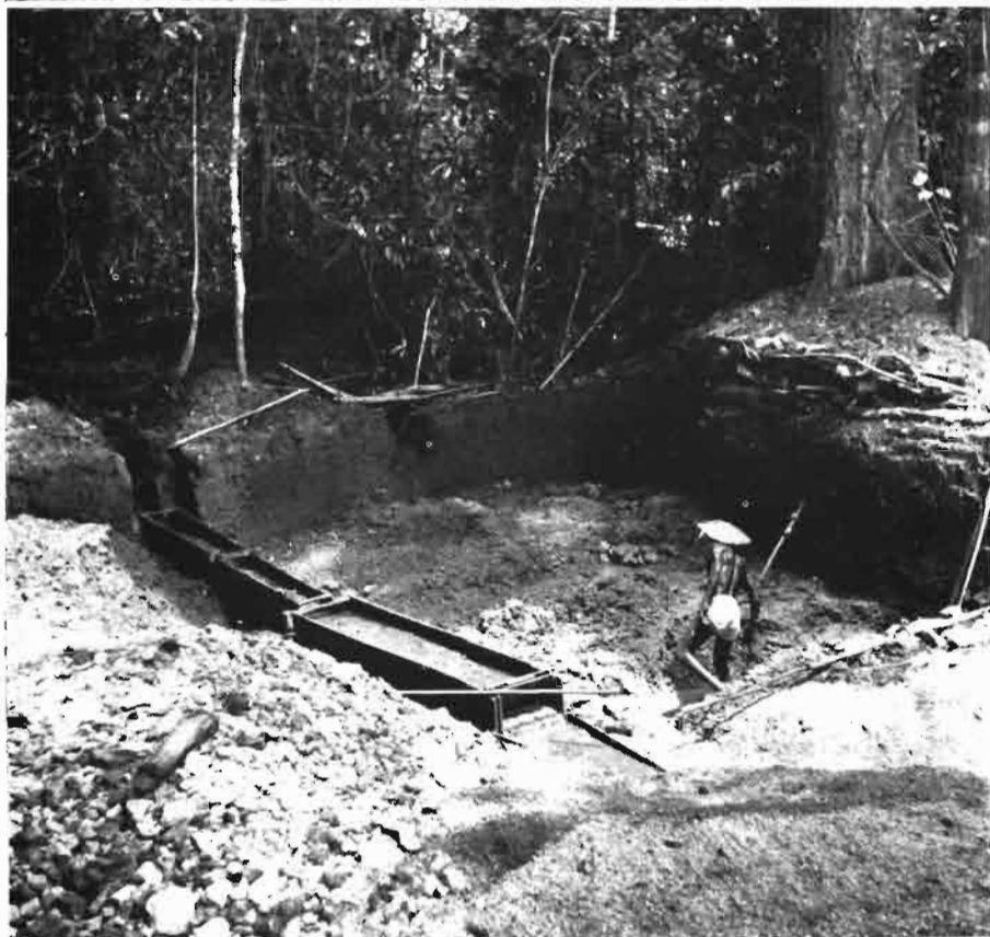
Fig. 1. — Exploitation aurifère alluvionnaire à Dorlain sur le Petit Inini. Travaux de décapage pour atteindre la couche minéralisée, surmontée par plusieurs mètres d'alluvions stériles.
