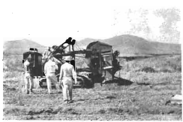
Creusement de fossés de drainage sur latosols humiques
