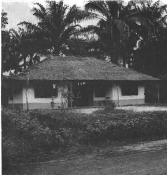
Habitation moderne. Murs en matériaux définitifs, et toit en tuile de palmier.
