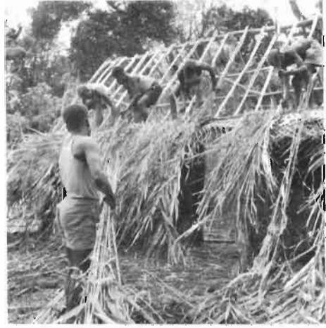
Travail de couverture (feuilles de cannes à sucre) d'une case de type récent. -- Yanēatēng.
