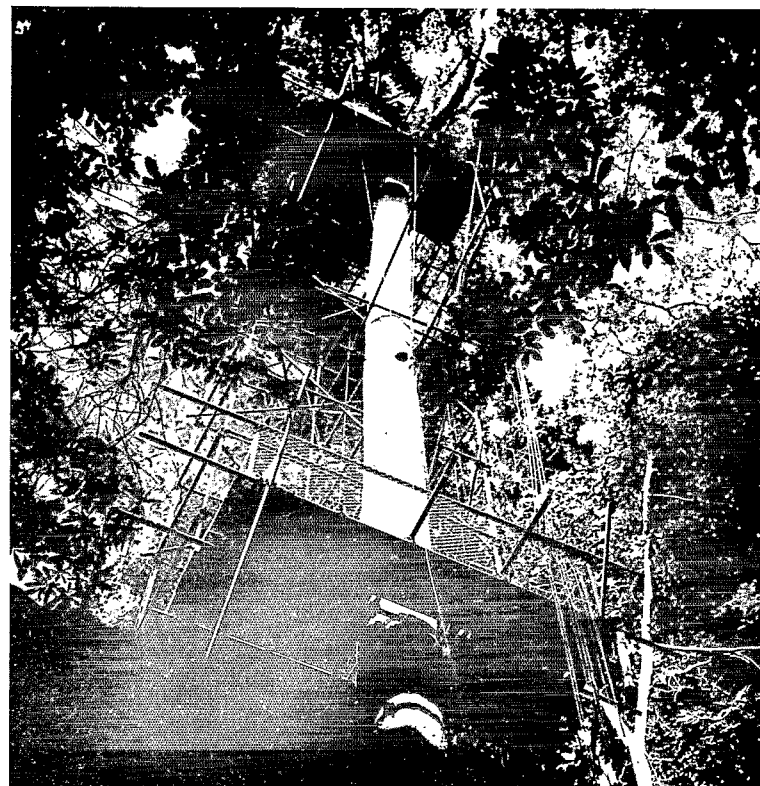
FIG. 1 et 2. — Deux vues de la tour construite entre deux arbres; les deux plateformes visibles sur les photographies, situées à 11 m et à 23 m entourent l'un d'eux.
