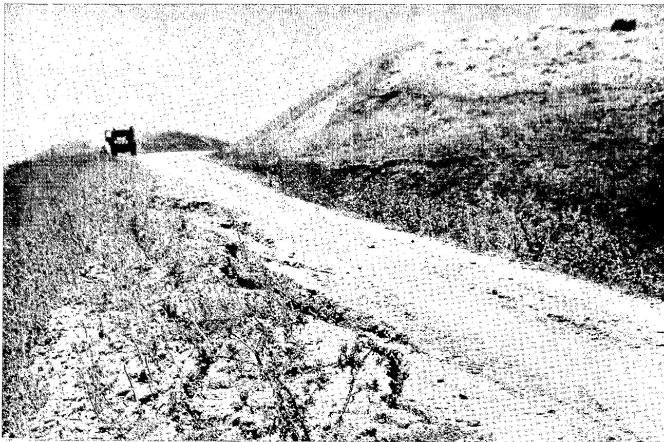
PHOTO 2. — Cisaillement et glissement de la chaussée au niveau d'un vallon mal drainé.
