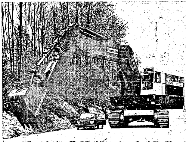
La EC 1000, la plus grosse pelle hydraulique construite actuellement.
