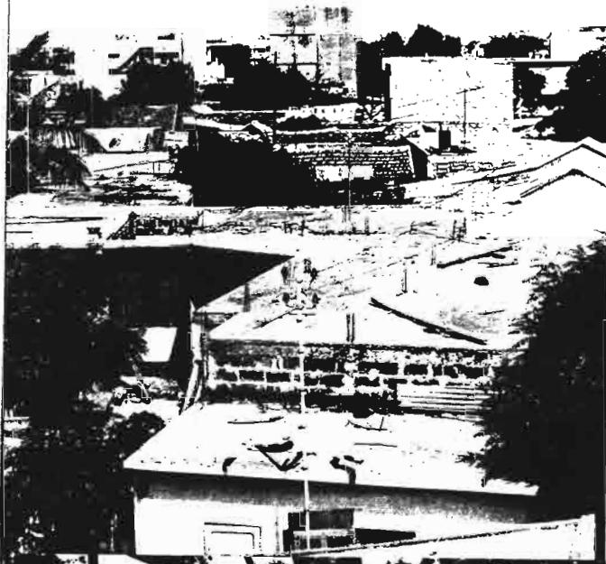
un Quartier en construction
