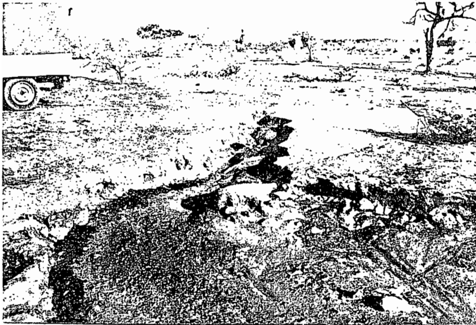
Figure 16 : Entaille linéaire due à un réseau de bourrelet anti-érosif non entretenu.
