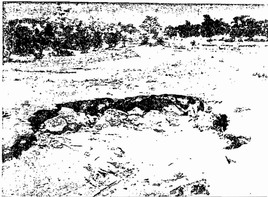
Figure 15 : Tête d'entaille prenant le relais du décapage en nappe (Les gravillons et concrétions ferrugineuses transportés sont un puissant abrasif).
