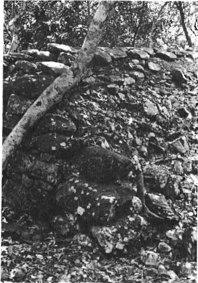
Figure n° 66 : Remplissage (Hakaohoka : upe 27).
