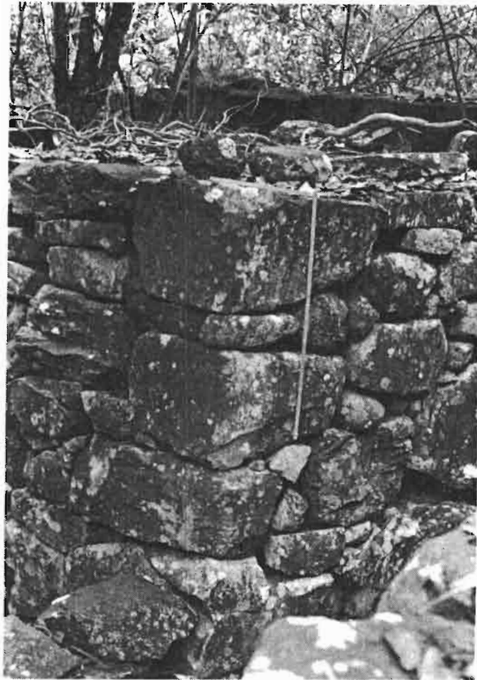
Figure n° 67 : Mur de façade (Hakaohoka : upe 23).
