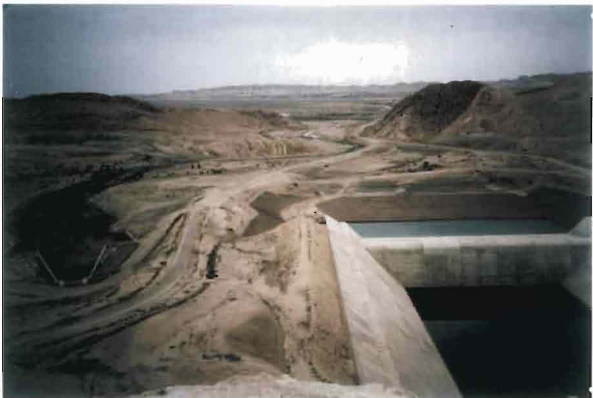
Le barrage de Sidi Saad, vue aval
