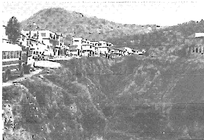
PHOTO 1. — Effondrement de vastes dimensions du 1/2/1984 dans l'Avenida de los Libertadores. La quebrada Navarro a rouvert son cours naturel, probablement suite aux phénomènes d'érosion interne dans le remblaiement dûs à deux hivers particulièrement pluvieux. Au fond le versant est de la Loma Ungüi, sur lequel se situe le bassin-versant de la quebrada La Raya. (Photo H. GODARD)
