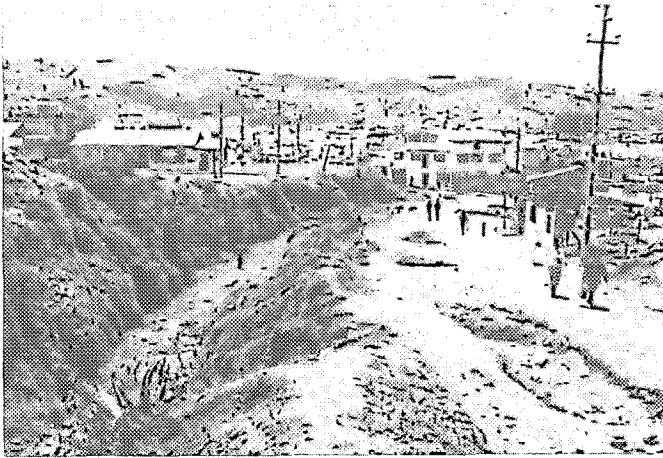
PHOTO 7. — Débouché de la quebrada dans l'urbanisation Santiago ; vue prise depuis la prise d'égout. On note dans le chemin, au premier plan, les traces d'effondrement de ce dernier. (Photo P. PELTRE)
