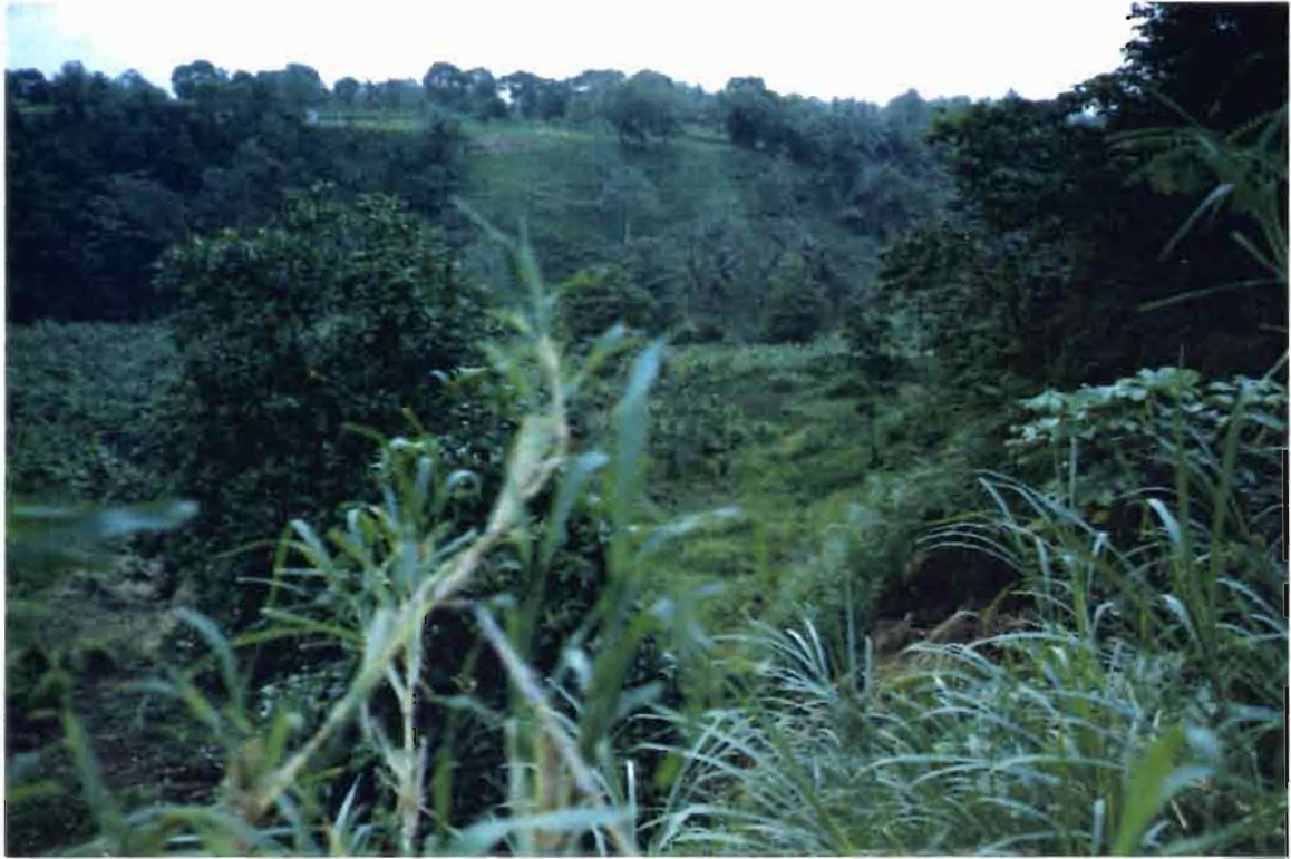
Site du Réservoir DUMANOIR côté aval
