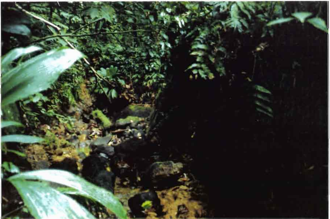
L'ancien canal MARQUISAT désaffecté, itinéraire de l'adduction au Réservoir DUMANOIR (19-04-1989)
