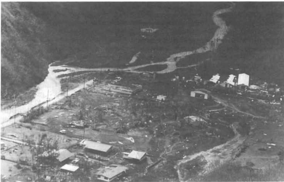
PHOTO 4. — Tahiti. Vallée d'orofero. Effets du vent (végétation) et destruction de cultures et de bâtiments (élevage industriel), en implantation risquée, cyclone Veena (avril 1983). Cliché Aéronavale
