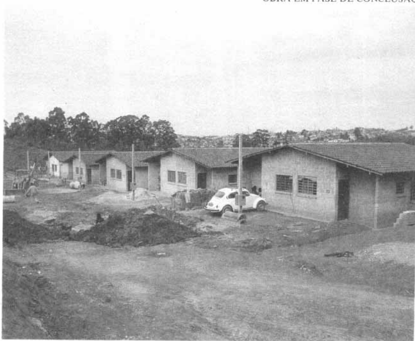
OBRA EM FASE DE CONCLUSÃO
