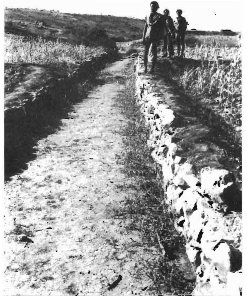
Photo 5.36 : Le canal de jonction qui amène l'eau jusqu'aux terrasses inférieures ; vue prise au point B de la figure 5.14 (J. Bennett, Andes Press Agency)
