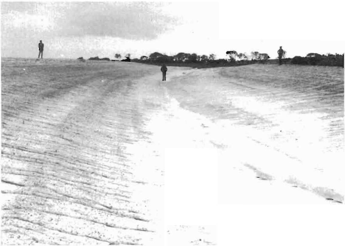
Photo 6.4 : l'érosion peut-être un problème sur les chemins d'eau "façonnés comme une route" dans un impluvium (I.A.F. Laing)
