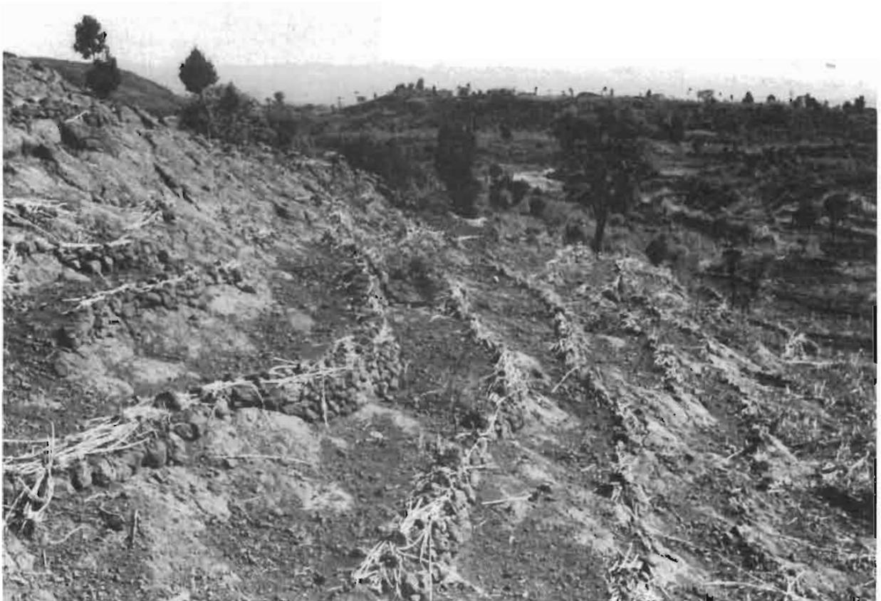
Photo 4.20 : simple microbarrage perméable (ligne freinant le ruissellement) constitué de pailles, de pierres et de terre à Konzo, Ethiopie (H. Hurni)
