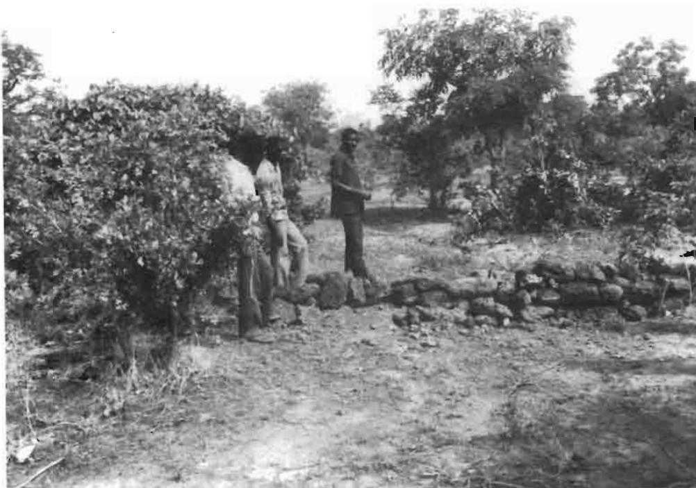
Photo 4.29 : petit seuil en pierres installé en travers d'une petite voie d'eau (ravineau) (G. Hallam)
