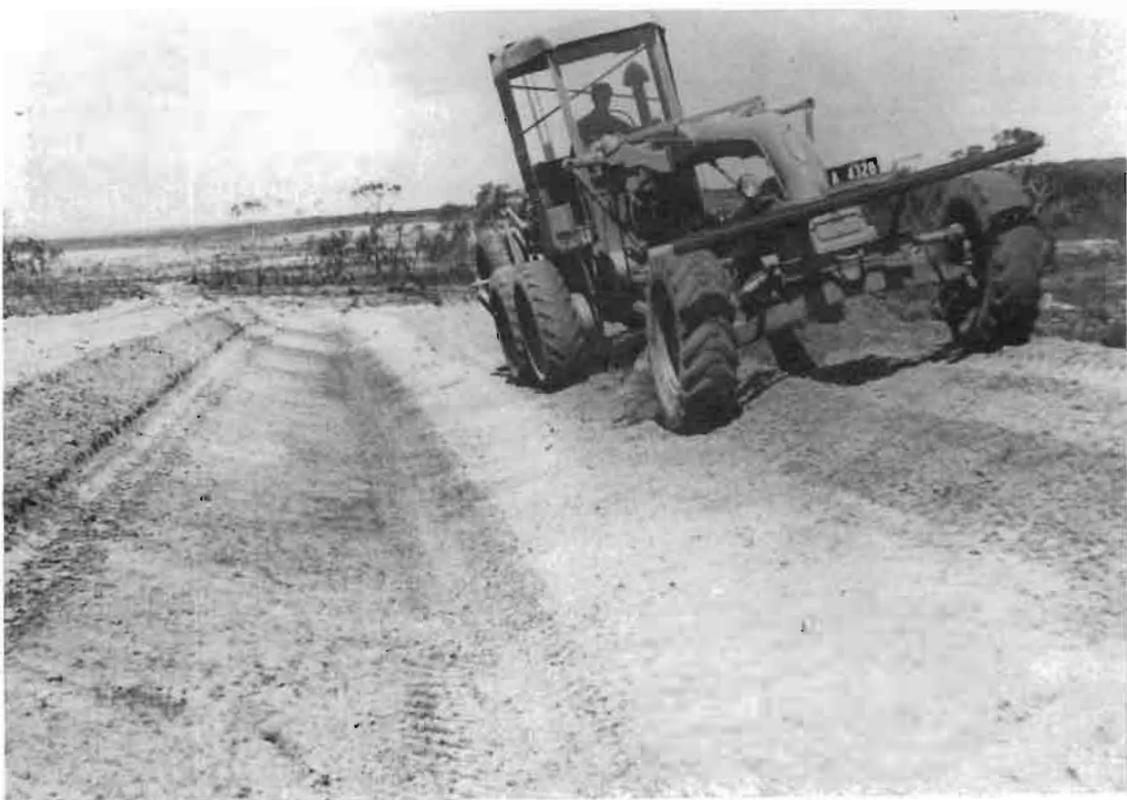
Photo 6.2 : façonnement de la surface du sol en vue de la récolte du ruissellement sur un impluvium damé comme une route (I.A.F Laing)
