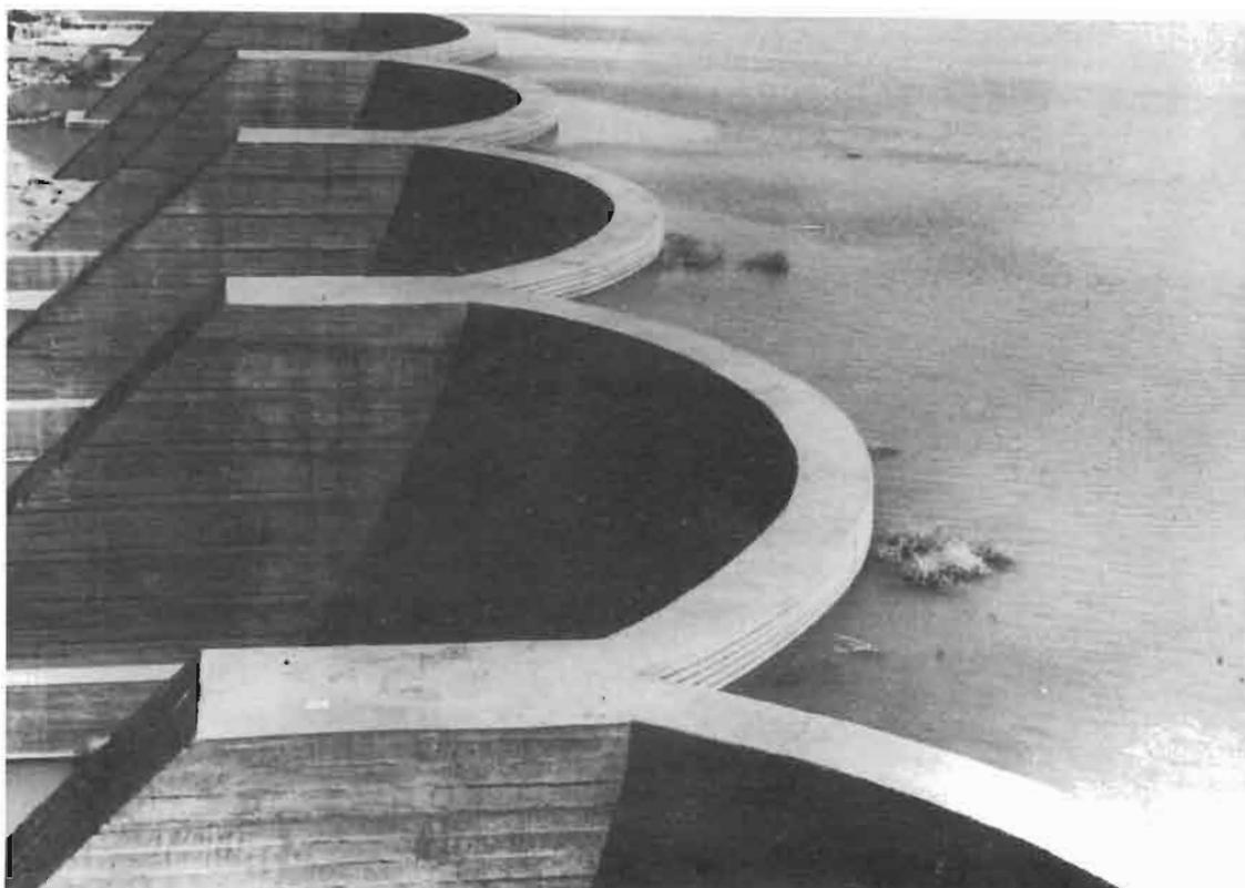
Photo 6.8 : un grand barrage piégeant les sédiments, Afrique du sud, utilisant une ingénieuse méthode de construction qui réduit le volume de béton consommé. Le coffrage des arches est réalisé avec des tôles ceintrées en fer
