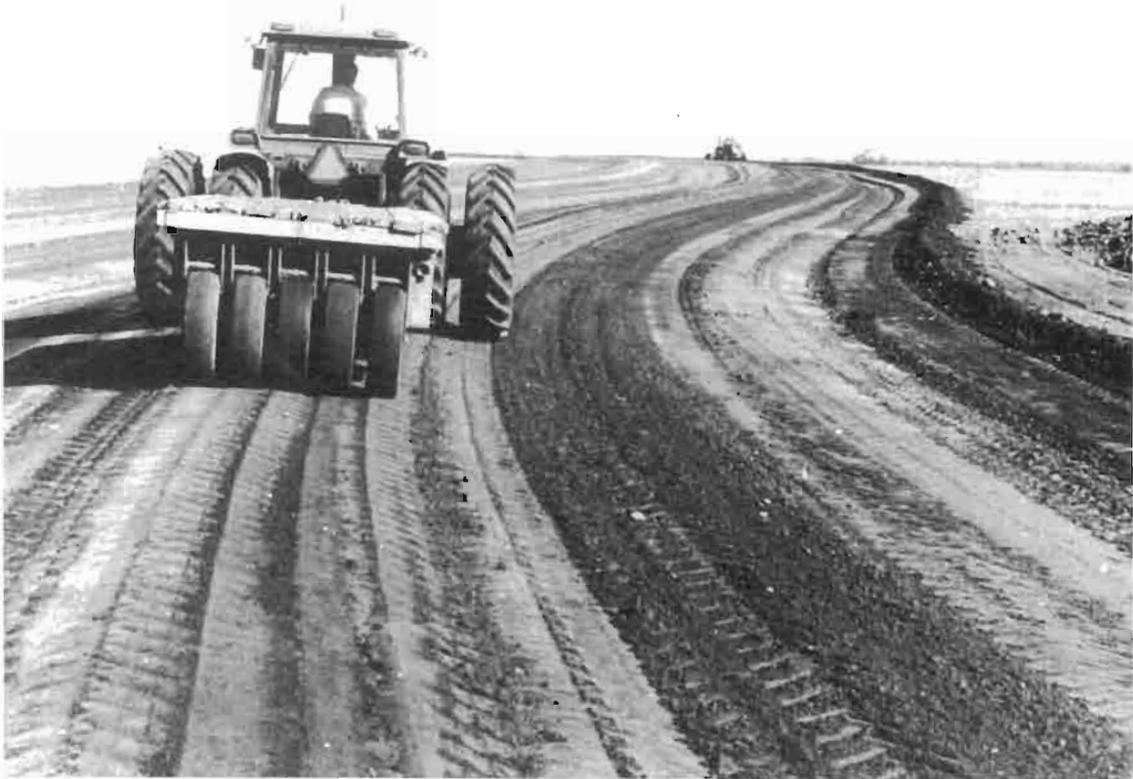
Photo 6.3 : lissage et compactage des chemins d'eau "façonnés comme une route" sur un impluvium en Australie (I.A.F. Laing)
