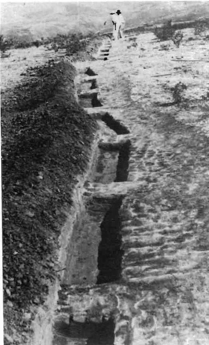
Photo 4.16 : fossé à flanc de colline avec drain à cloisons et déversoir (USDA)
