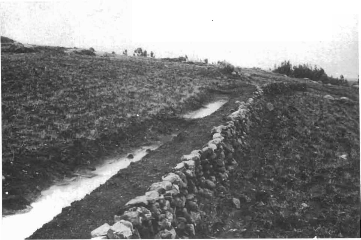
Photo 5.13 : Banquettes construites suivant les courbes de niveau en Ethiopie, avec cloisonnement à l'intérieur du fossé et muret de pierres renforçant le talus (H. Hurni)
