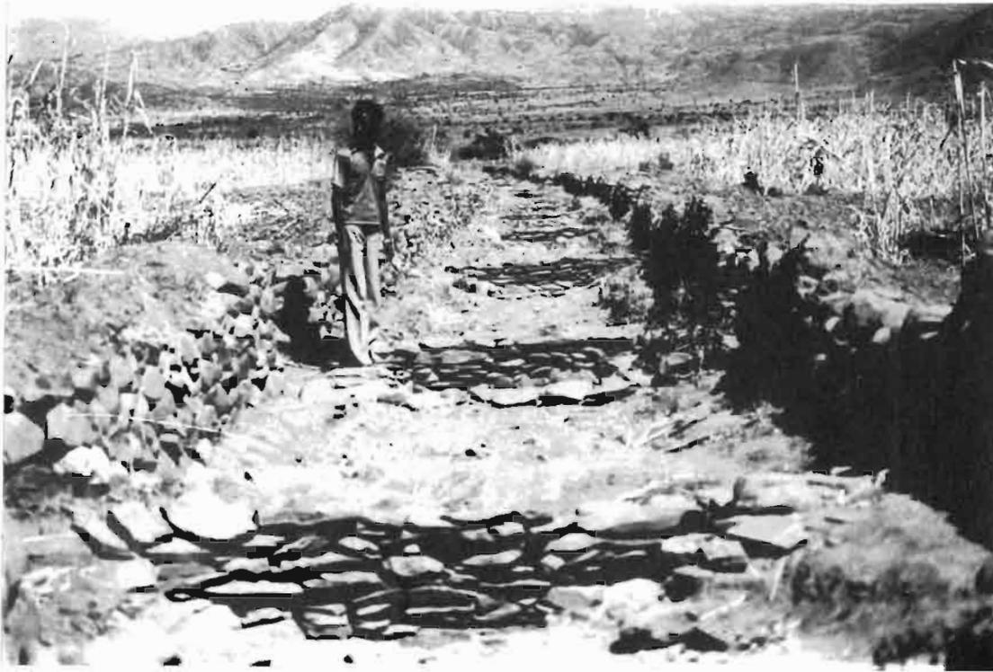
Photo 5.35 : Ouvrages de dérivation des eaux de crue au Tigré, Ethiopie. Vue prise au point A de la figure 5.14 (J. Bennett, Andes Press Agency)
