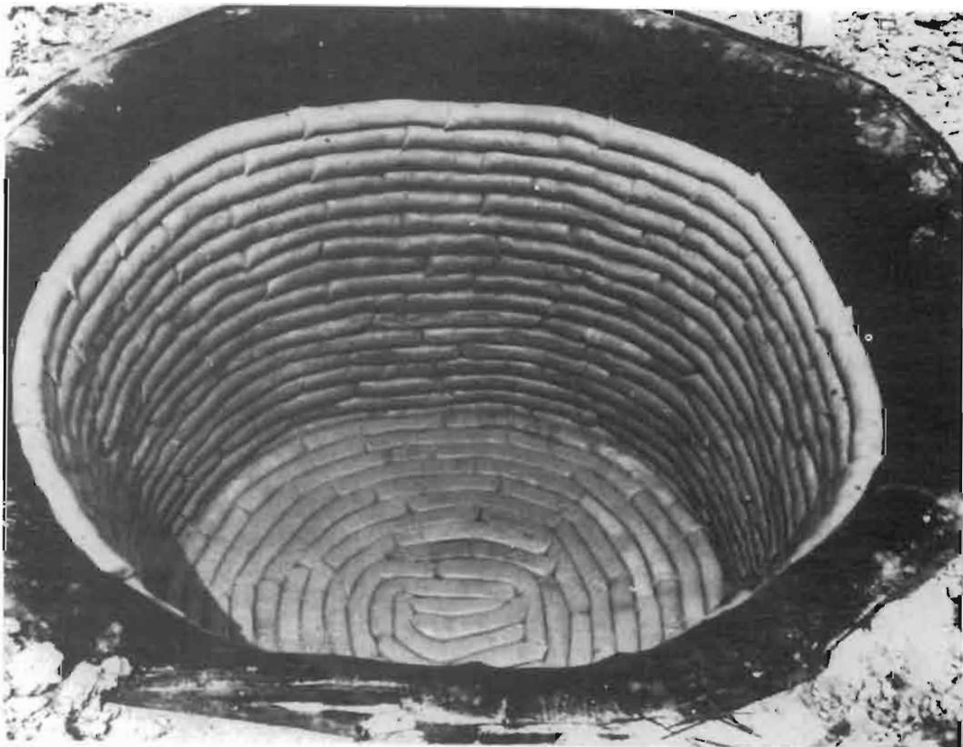
Photo 6.9 : deux exemples de réservoirs d'eau construits par la méthode des saucisses (groupe de développement de méthodologie intermédiaire)
