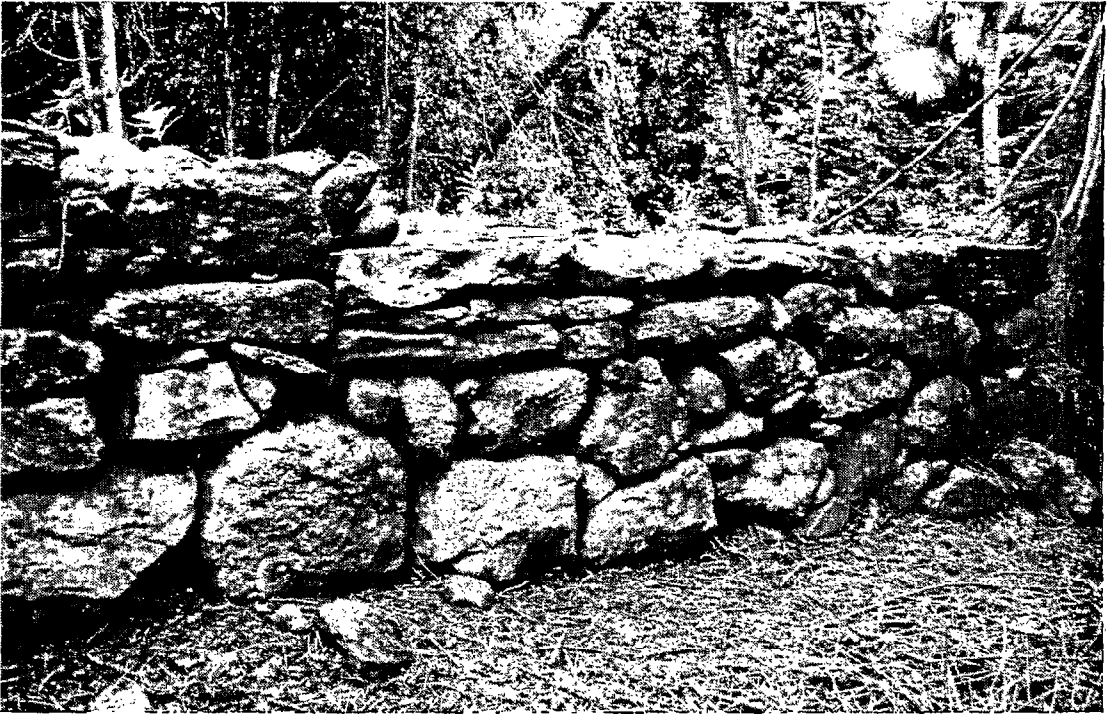
Figure n° 17 : Appareillage d'un mur latéral.
