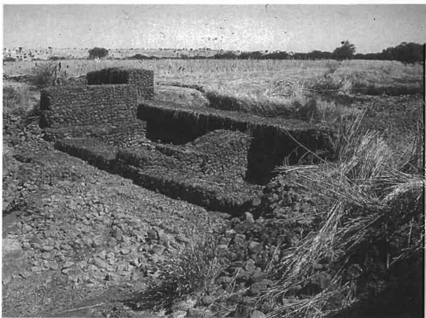
8. Tahoua (Niger) : Barrages en pierre protégés par les gabions.
