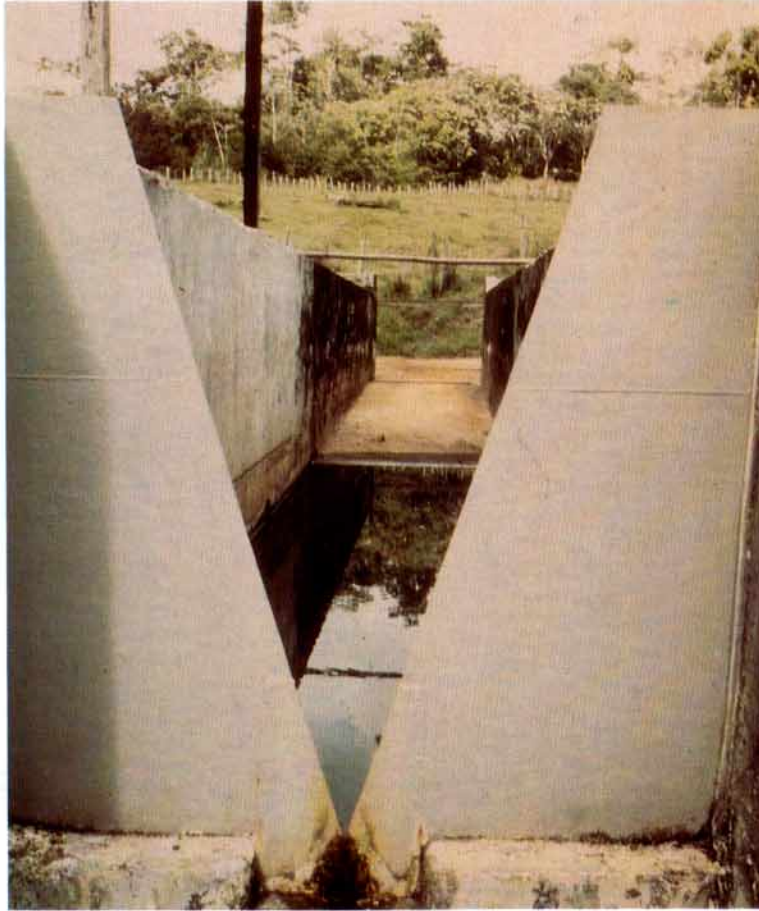
Déversoir en V à 30^\circ , à l'aval de la fosse à sédiments (bassin A)
