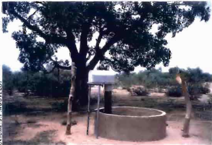
Puits équipé d'un limnigraphe - Bidi - (Burkina-Faso)
