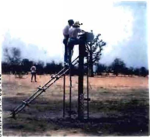
Tour de limnigraphe en tubes métalliques
