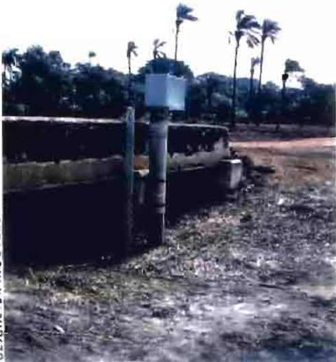
Limnigraphe et échelle scellés sur un pont - Djiguinoum - (Sénégal)
