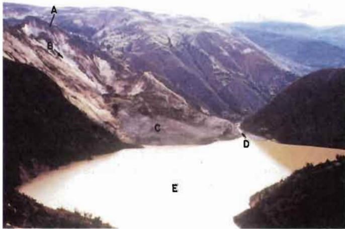
Fig. 2 - Vue du glissement et du lac depuis l'amont, un jour avant la rupture (photo C. Menendez). (A) Tête du glissement ; (B) Direction du mouvement ; (C) Accumulation des matériaux ayant glissé ; (D) Canal creusé dans la partie la plus basse du glissement ; (E) Lac accumulé en amont du glissement.
