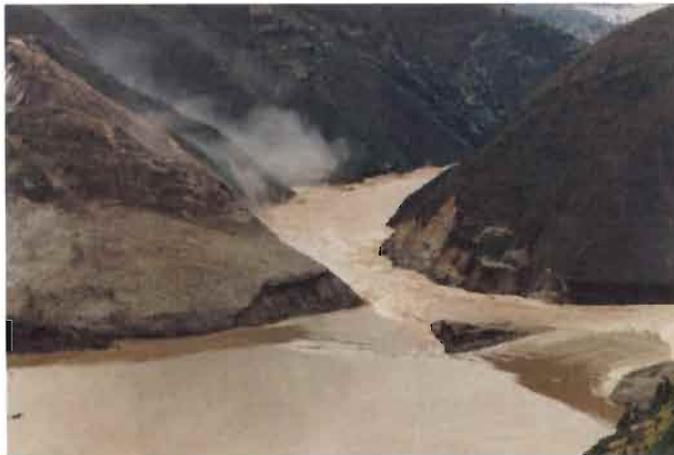
Fig. 6 - L'érosion exponentielle réelle du barrage de la Josefina.
