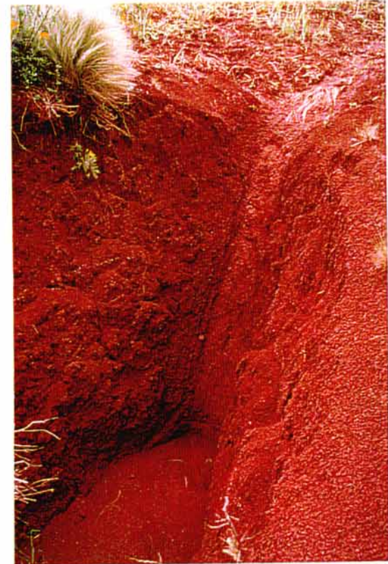
Photo 11. Détail de la chute en sortie de banquette en bord de piste
