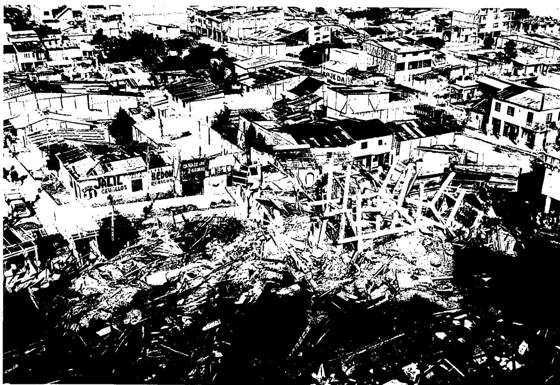
Foto. 9: Casas destruidas en la parte baja del deslizamiento de la 10 de Agosto
