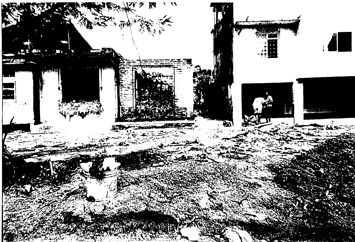
Foto. 1: Destrucción de varias casas por un flujo de lodo
