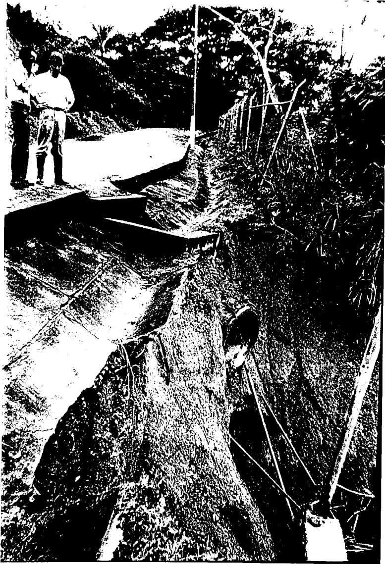
Foto. 11: Erosión regresiva en el talud de una carretera
